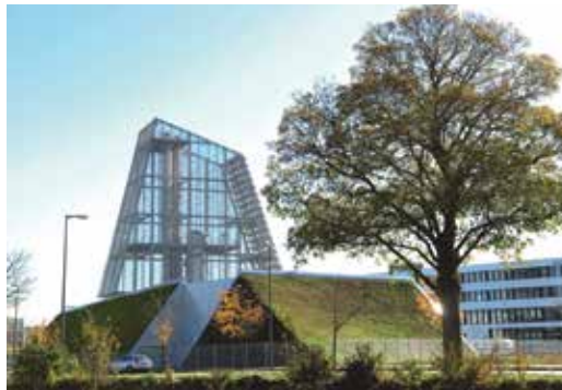
Blick auf das Geothermie-Heizwerk Freiam
