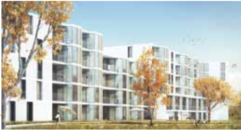
Das Wohnbauprojekt der GWG
