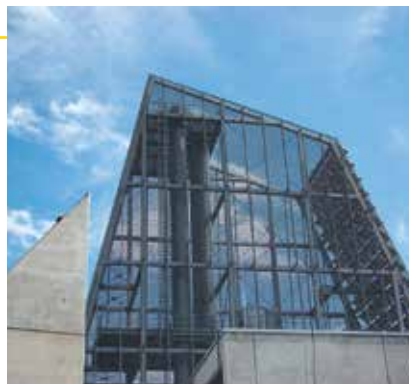
Die Geothermieanlage an der Bodenseestraße
