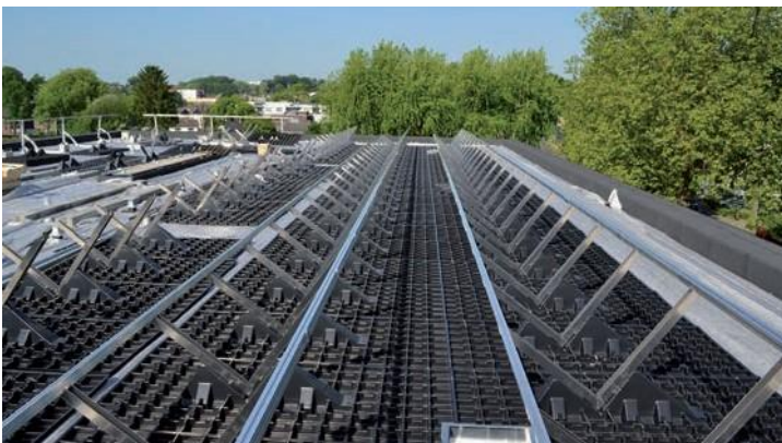
Abb. 6: Auflastgehaltene und begrünbare Unterkonstruktion zur durchdringungsfreien Aufständigung von PV-Modulen (Foto: Opti-grün international)
