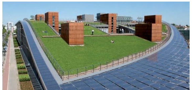
Abb. 2: Produktions- und Verwaltungsgebäude in Berlin-Adlershof (Schulte-Frohlinde Architekten, Berlin; Quelle: SeV Bayern)
