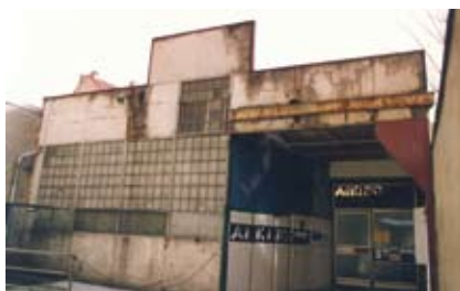
Ehemalige Gewerbehalle rückwärtig, Preysingstraße 28/Steinstraße 36–38
