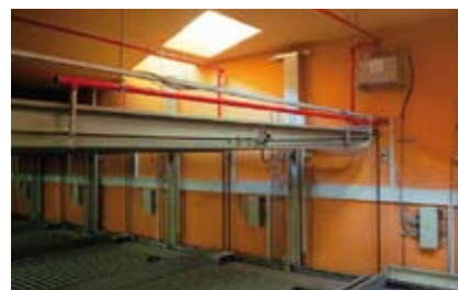
Duplex Parkplätze in Gemeinschaftstiefgarage
