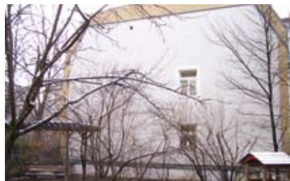
Fenstereinbau an Rückgebäude Comeniusstraße 3, Grundstücksgrenze Milchstraße 14
