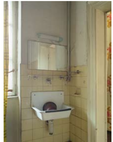
Wasserhahn mit großem Ausgussbecken in Altbauwohnung
