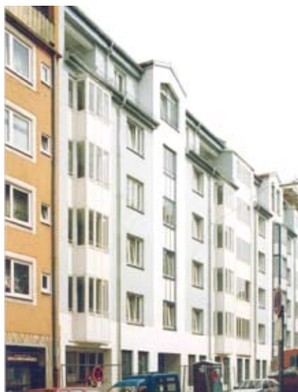
Neubau Sedanstraße 35 und 37
