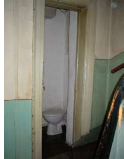
Toilette auf halber Etage
