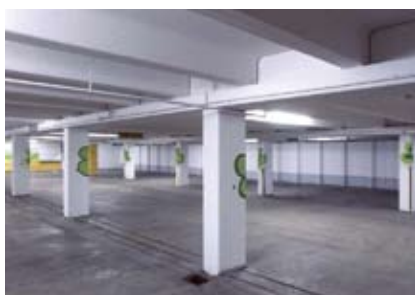
Die neue Tiefgarage unter der Postwiese
