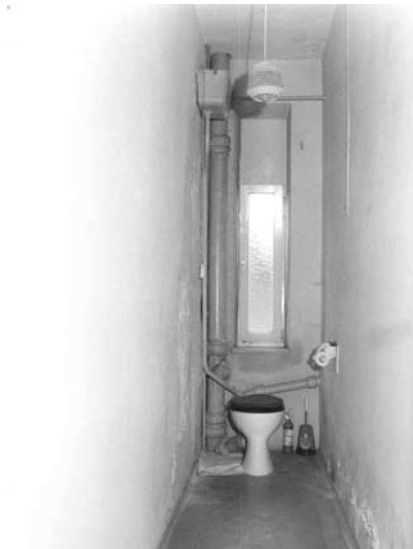
Schmale Toilette („Schlauch-Klo“) in einer Altbauwohnung
