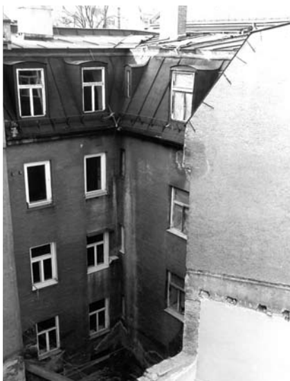
Würthstraße 22, zweites RG vor Abbruch
