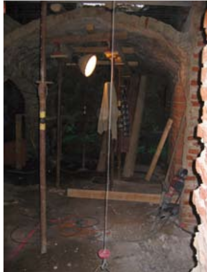
Gemauertes Tonnengewölbe, Trockenlegungsarbeiten
