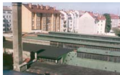
Hallen des ehemaligen Möbellagers Sedanstraße 35
