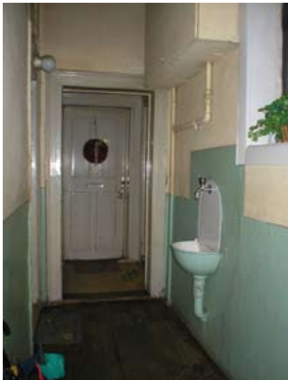
Wasserhahn mit Ausgussbecken im Treppenaufgang
