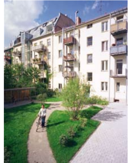
Gartenzone Rückseite Kellerstraße 28 - 32, Sanierungsblock 20
