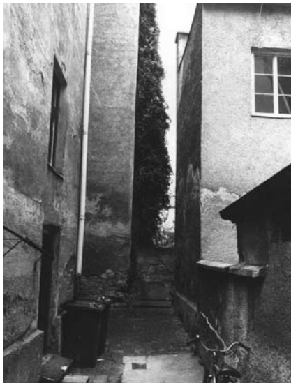
Unzureichende Belichtung und Belüftung
