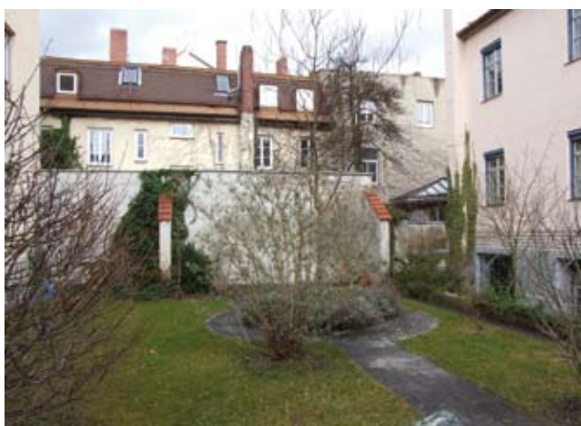
Wohnumfeldverbesserung, Pütrichstraße 3a. Durch Abbruch eines gewerblichen Neben- gebäudes wurde eine Grundstücksgrünfläche geschaffen: Sanierungsblock 7.
