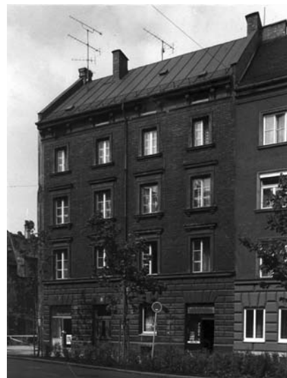
Steinstraße 46 (BD, Bj. 1886, Mietshaus, Neurenaissance, Rohbackstein mit Putzgliederungen)
