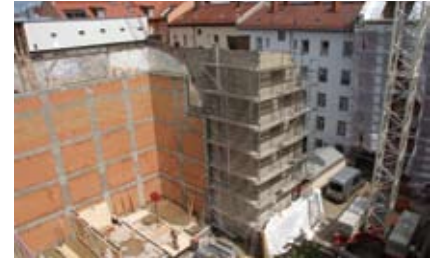
Neubau des Rückgebäudes Pariser Straße 11 in Holzbauweise
