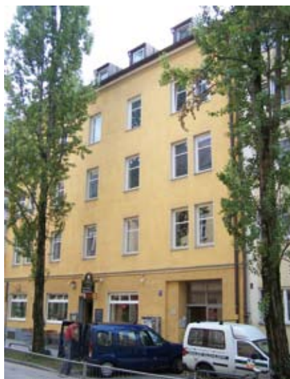
Gravelottestraße 14 nach Sanierung
