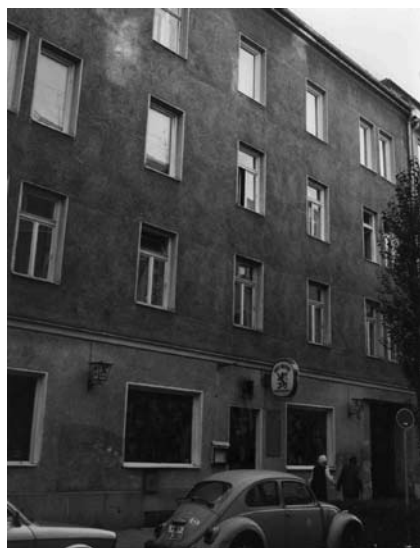
Gravelottestraße 14 vor Sanierung
