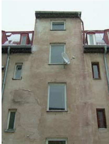
Treppenhaus auf der Rückseite eines mehrgeschossigen Altbaus der Gründerzeit
