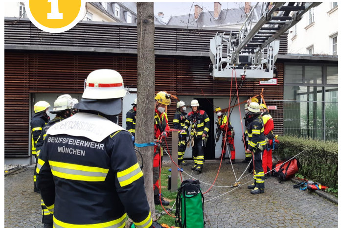
APRIL | Pkw stürzt in Aufzugschacht
