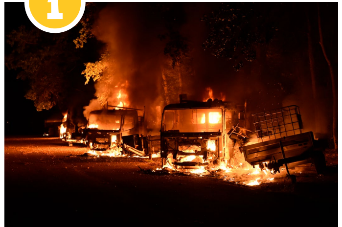
JULI | Kabeltrommeln und Baufahrzeuge in Brand
