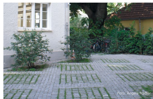
Entsiegelung und ortsnahe Versickerung von Niederschlagswasser sind wichtige Themen der Grundstücksentwässerung. Das Foto als Beispiel zeigt ein Rasenfugenpflaster in einem Innenhof.
