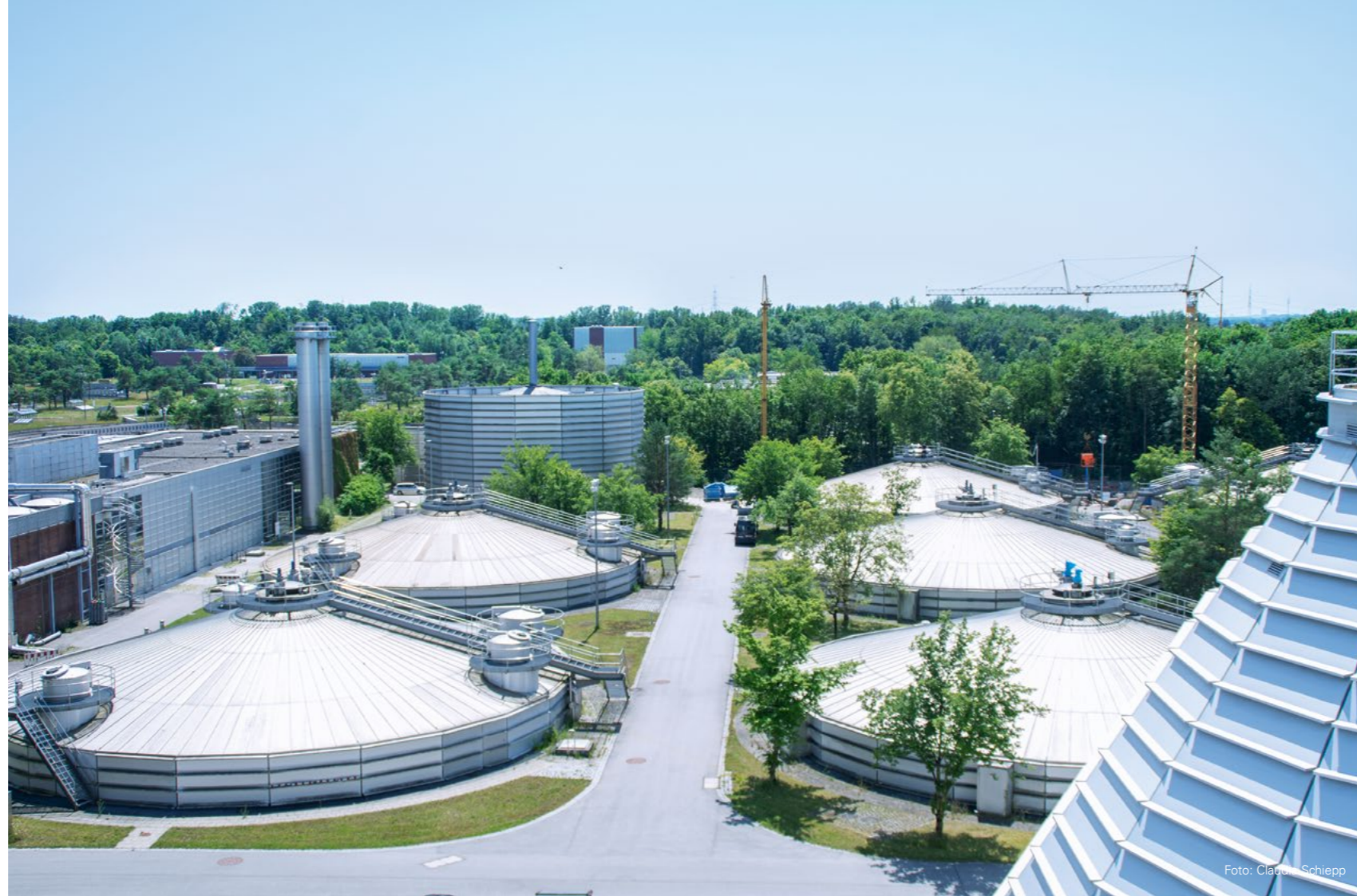
Zuverlässige Abwasserreinigung 24 Stunden an 365 Tagen im Jahr
