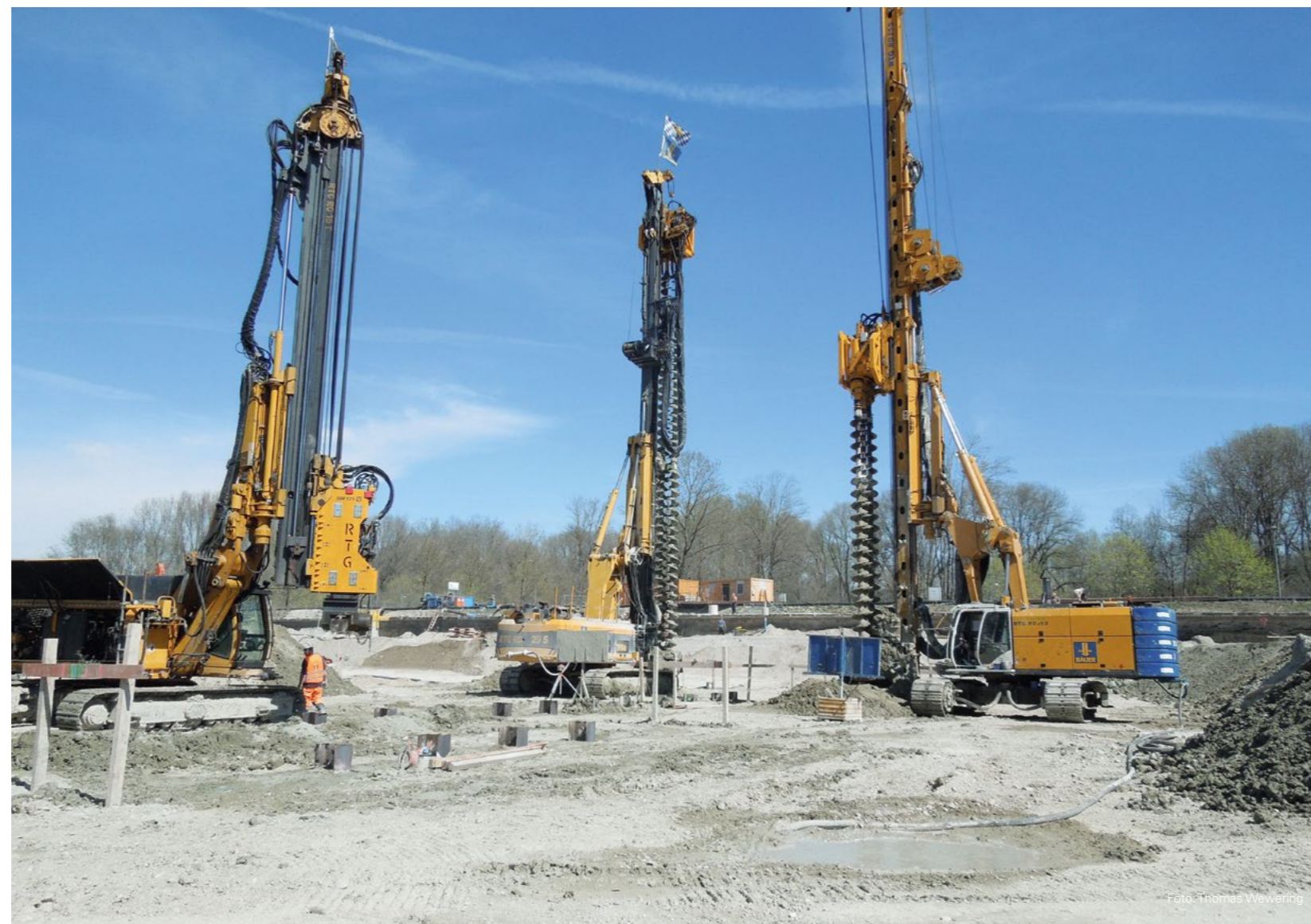
Pfahlgründungen für den anstehenden Tiefbau
