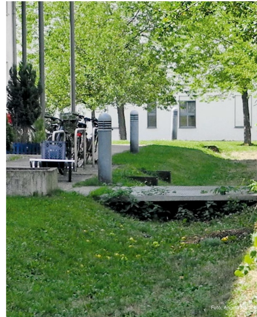
Versickerung in eine Mulde im Vorgartenbereich
