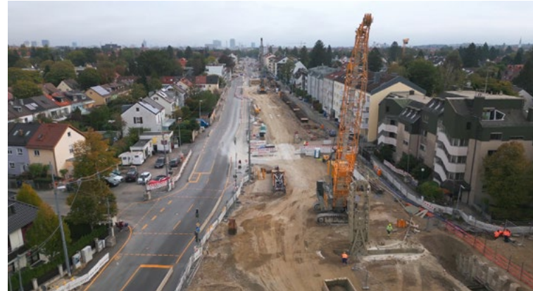
Blick entlang der Baustelle
