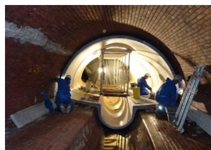
Großprofilisanierung mittels vorgefertigter Rohrprofile
