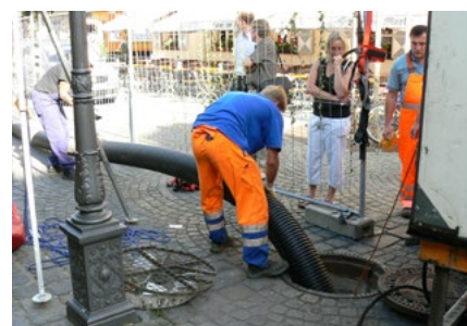
Einziehen eines vorgefertigten Rohrstranges in einen nicht begehbaren Kanal
