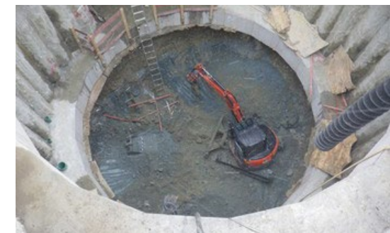
Abbruch der Mergelschicht in der Startgrube (Dükeroberhaupt).
