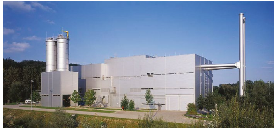
In der Klärschlammverbrennungsanlage werden jährlich rund 792.000 Kubikmeter Klärschlamm aus beiden Klärwerken verbrannt.
