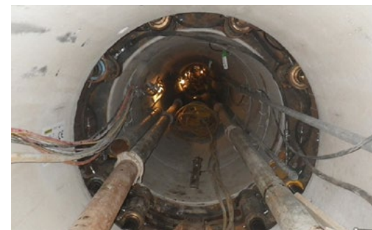
Vortriebsrohre während laufender Vortriebsarbeiten.
