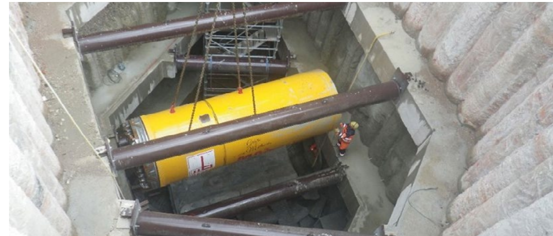
Bergen der Vortriebsmaschine in der Zielbaugrube (Dükerunterhaupt).
