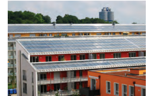
Solarkollektoren im Quartier Nord-West
