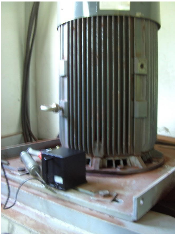
Abb. A6.6: WKA Generator am 15.5.2012
