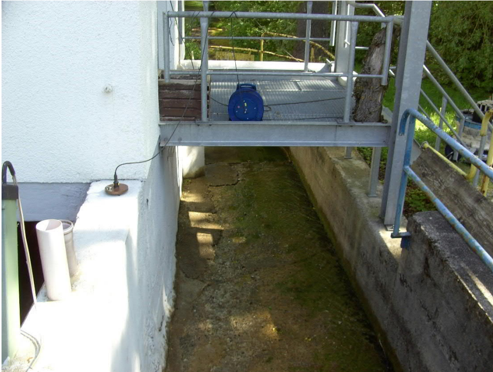
Abb. A6.5: WKA Streichwehr für Überlauf am 15.5.2012
