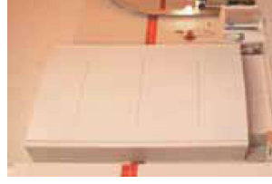
Wohnungsübergabestation mit einem Wärmeübertrager für die Trinkwassererwärmung
