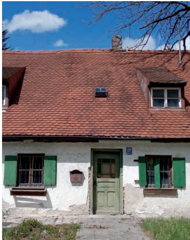
Eingeschossiges, ehemaliges Bauernhaus mit allen Elementen vorindustrieller Bauweise.
