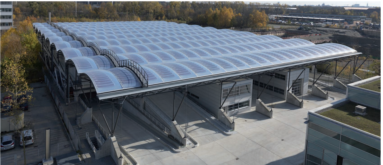
Abb. 8: Pneumatisch vorgespannte mehrlagige ETFE-Kissen kombiniert mit flexiblen Dünnschicht-PV-Modulen – Überdachung des Carports des Abfallwirtschaftsamts München (Ackermann und Partner Architekten; Quelle: SeV Bayern).
