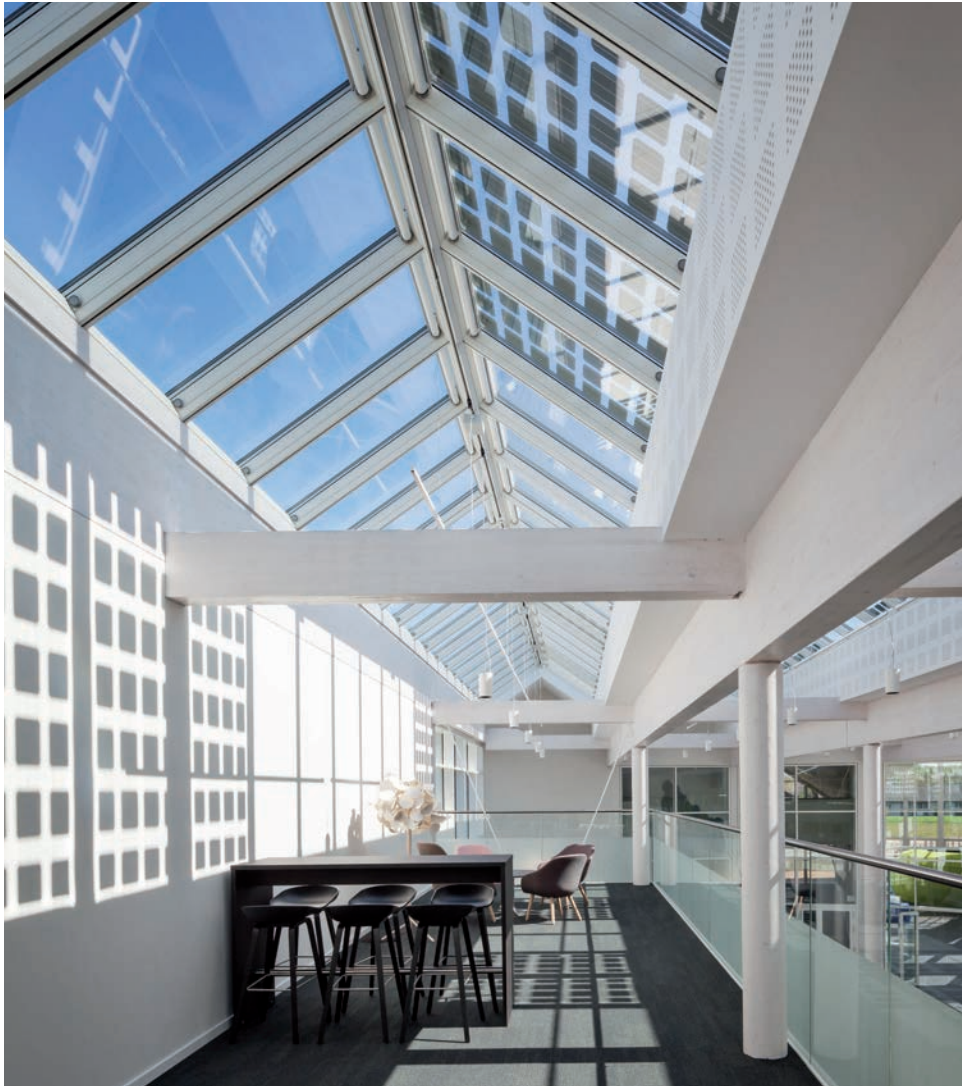
Abb. 1: Verglastes Sattellichtband mit PV-Modulen in südorientierter Dachfläche als Sonnenschutz über Innenraum – Green Solution House, Rønne (GXN/3XN; Foto: Stammers Kontor, Quelle: SeV Bayern).
