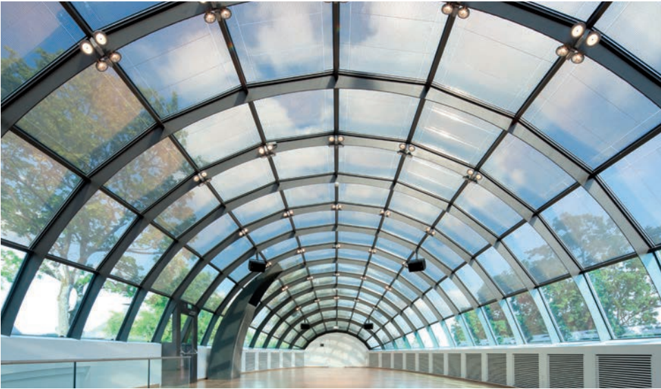
Abb. 7: Glaskuppel mit Sonnenschutzgläsern und semitransparenten Dünnschichtmodulen mit Transmissionsgraden von 10 und 20 % – Akademie Deutscher Genossenschaften, Schloß Montabaur (Foto: Glaswerke Arnold, Quelle: SeV Bayern).
