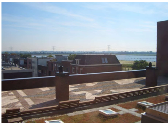
Beispiel gemeinschaftlich genutzter Dachgarten, Woerden, NL (West8)
