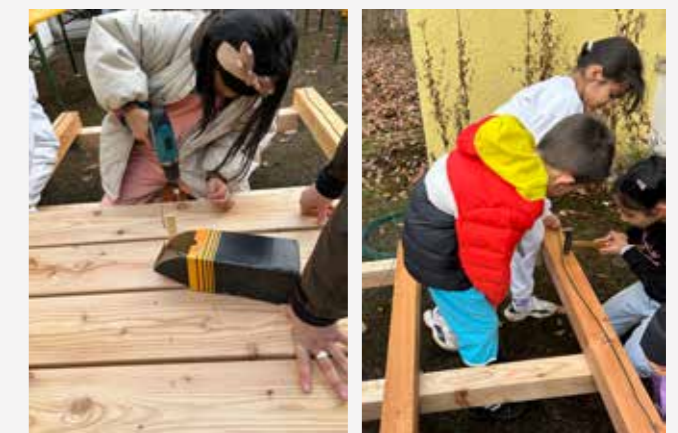
Bauworkshop für ein Holzpodest mit einer dritten Klasse. Fotos: Urbanes Wohnen e. V. München
