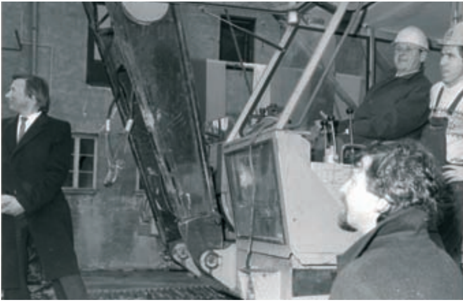
1982: Oberbürgermeister Erich Kiesl beim Spatenstich für Block 50.
