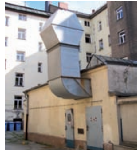
Blick in den Hinterhof der Pariser Straße 11 vor den Sanierungsarbeiten.
