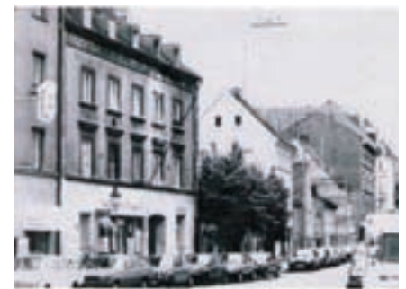
Blick in die Kirchenstraße vor den Erneuerungsmaßnahmen.
