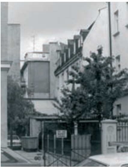
Hinterhöfe in der Metzstraße 23 bis 25 vor der Sanierung.
