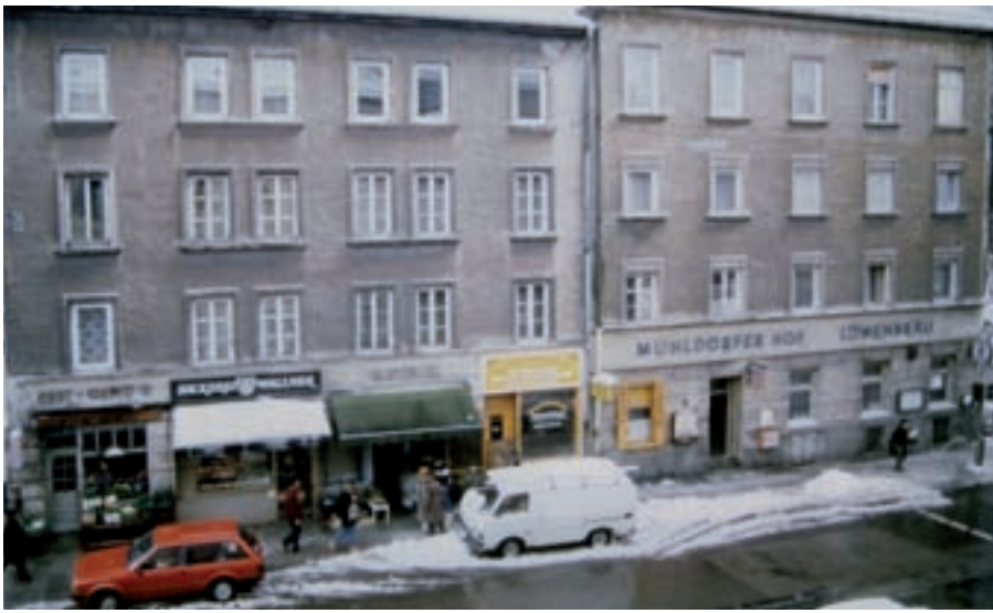
Das alte Ladengeschäft der Bäckerei Wallner vor der Sanierung. Die Backstube war im Keller unter dem Mühldorfer Hof untergebracht.
