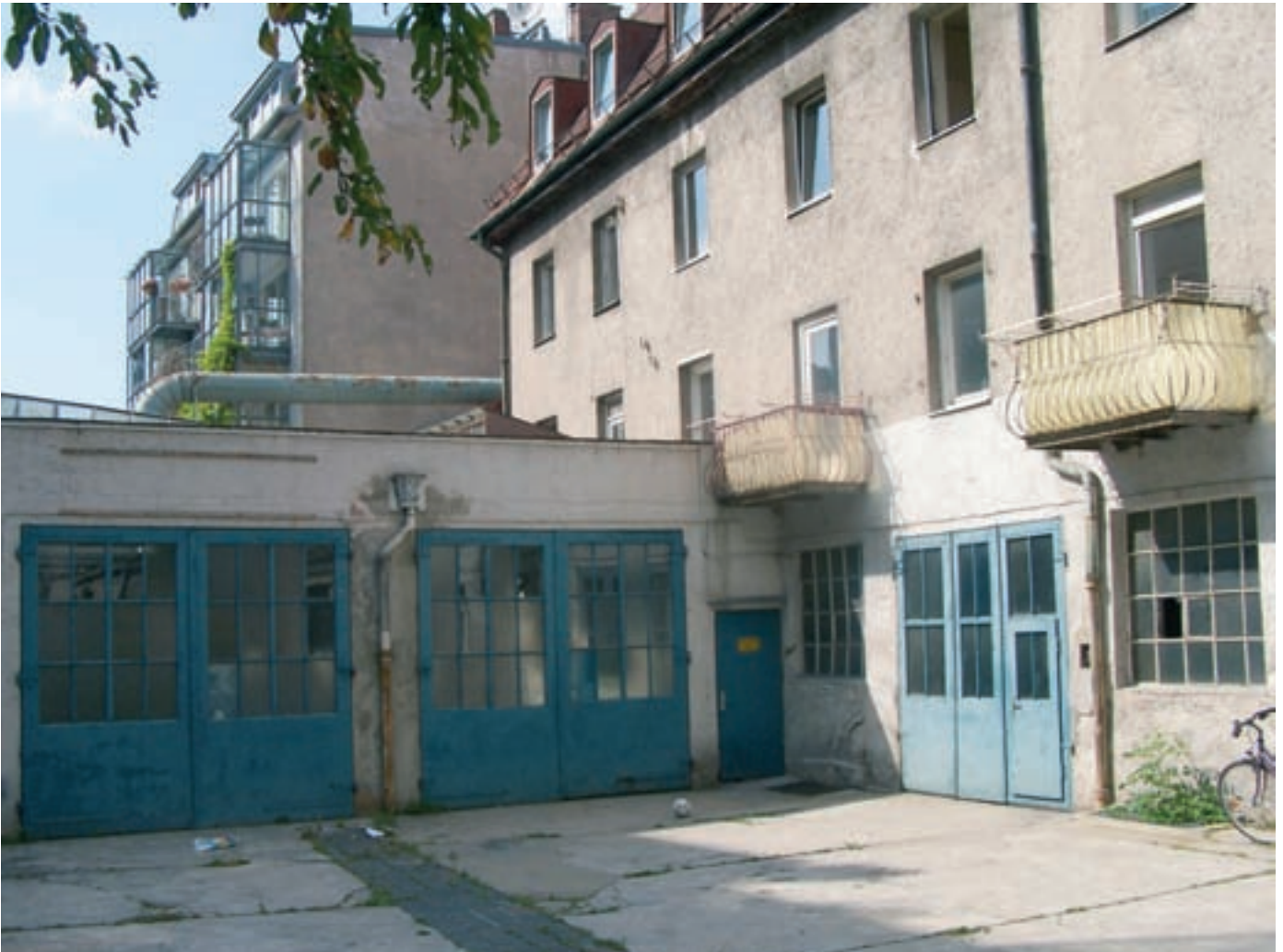
Ein gewerblich genutzter Hinterhof in der Pariserstraße 11, vor der Sanierung.
