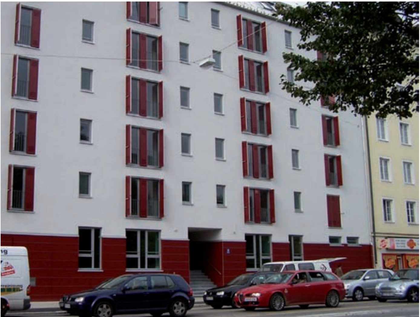
Das Clearinghaus in der Orleansstraße
