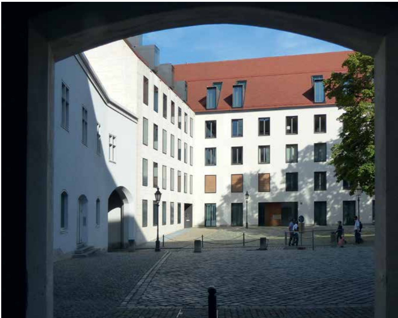
Der neue Brunnenstock im Anschluss an den Lorenzstock
