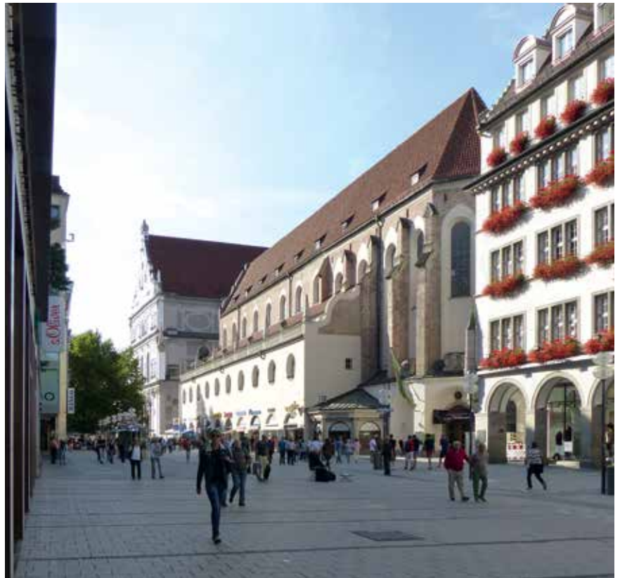
Augustinerkirche und Michaelskirche, im Krieg schwer beschädigt
