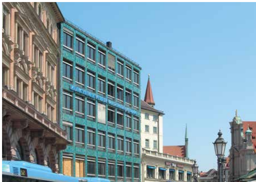
Viktualienmarkt 6 mit keramischer Skelettfassade vor dem Umbau
