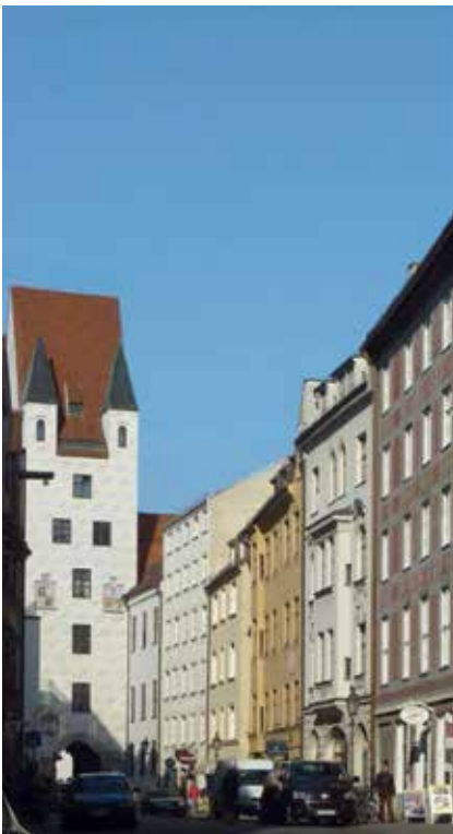
Blick in die Burgstraße nach Norden mit wiederaufgebautem Torturm des Alten Hofes
