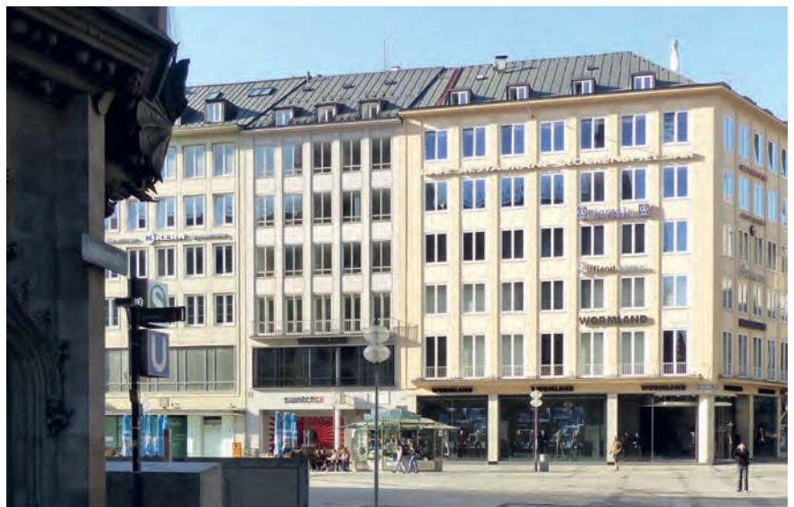
Südseite Marienplatz mit drei zeittypischen Fassaden der Wiederaufbauphase
