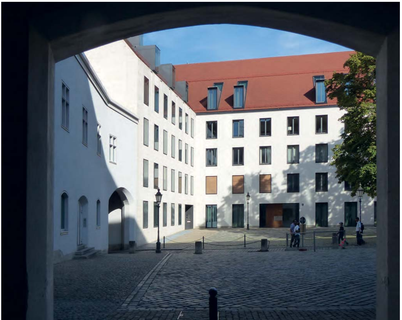
Der neue Brunnenstock im Anschluss an den Lorenzistock
