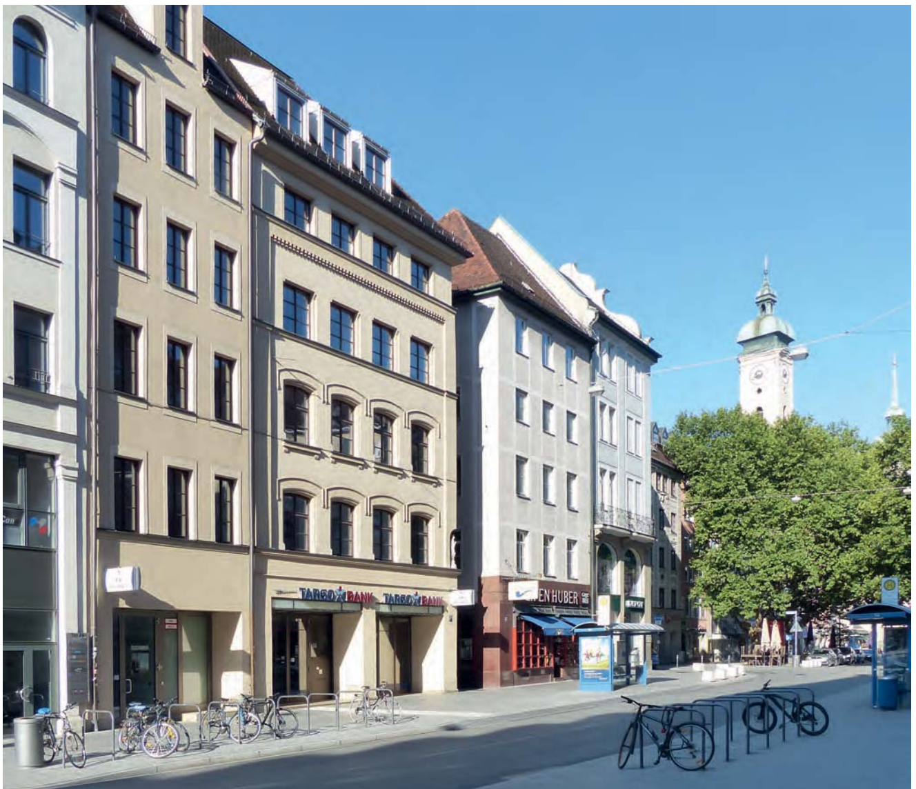
Südseite Parzellenbebauung im Tal
