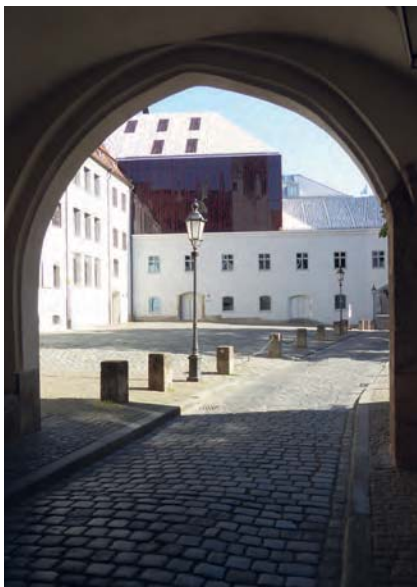
Blick auf den umgebauten Lorenzstock
