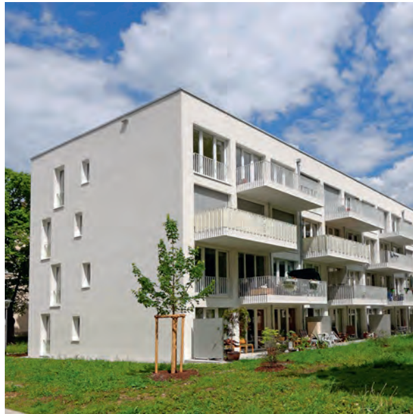
Links: Passivhaus der GEWOFAG am Piusplatz (Planung: Allmann Sattler Wappner Architekten, München), oben: Wasserkraftwerk an der Isar. Großes Bild, linke Seite: Solare Nahwärme am Ackermannbogen (Planung: Götze Hadlich Popp Streib Architekten, München)
