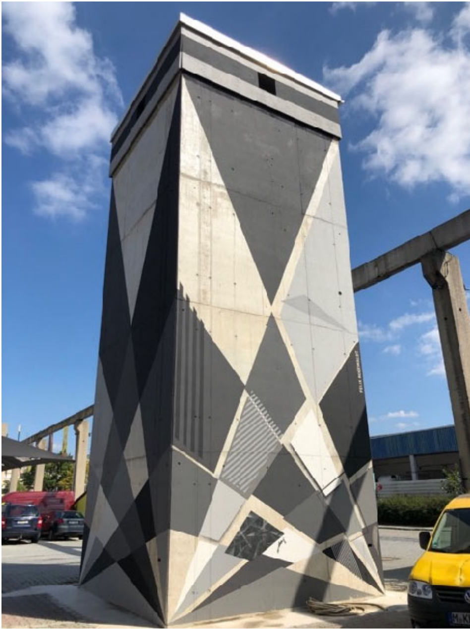
Abbildung 5: Fledermausturm, 2021 fertig gestellt. (Foto: Gerges 2021)
