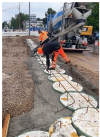
Bauarbeiten für die Verlängerung der U5 nach Pasing
