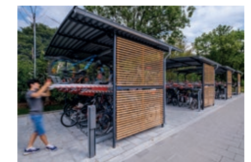
150 Fahrradabstellplätze an der U-Bahn-Station Quiddestraße
