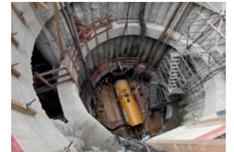
Montglasstraße: Bau eines Dükers unter der Isar
