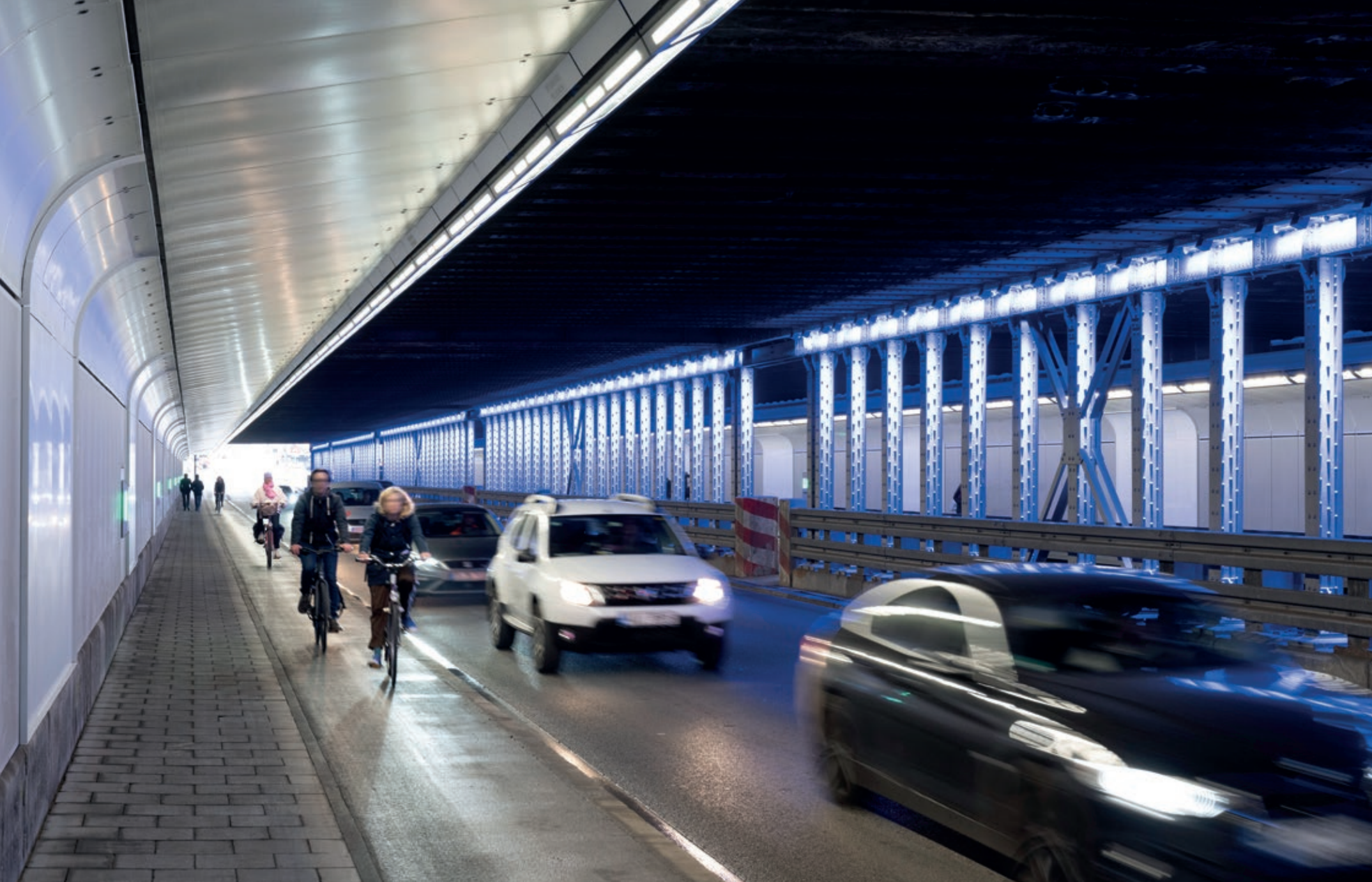
Deutlich heller und sicherer: die aufgewertete Paul-Heysel- Unterführung
