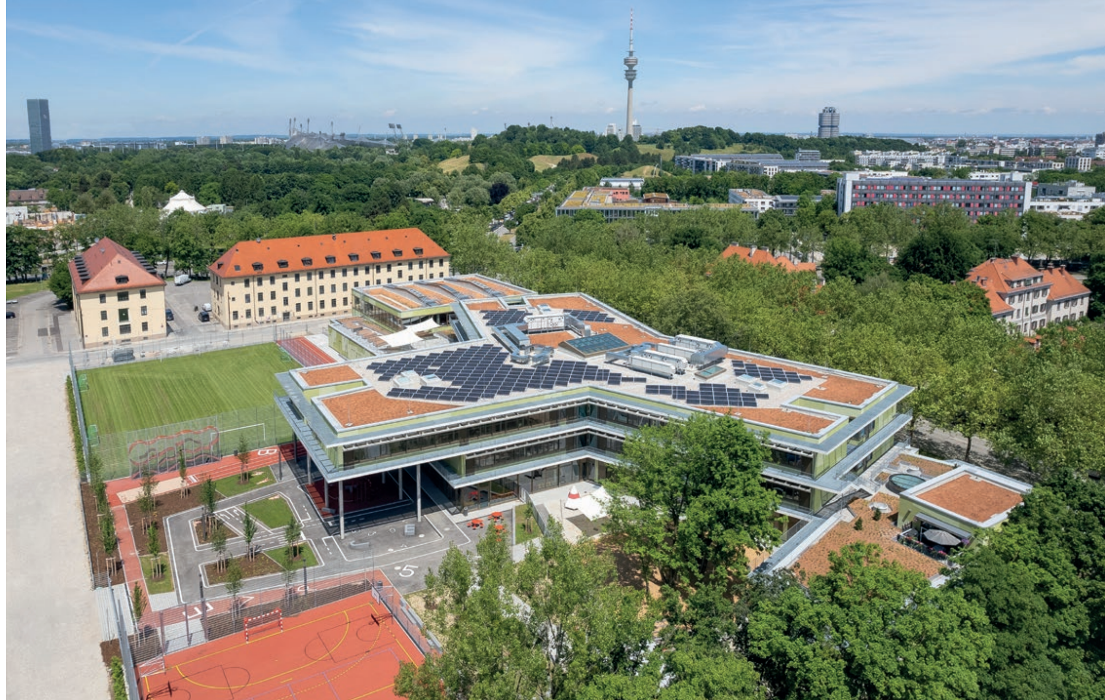
Photovoltaikanlage auf dem Dach der Grundschule Infanteriestraße
