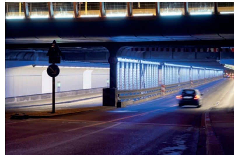
Eine ergänzende LED-Beleuchtung mit metallisch blauem Licht inszeniert die historische Stahlkonstruktion der Paul-Heyse-Unterführung
