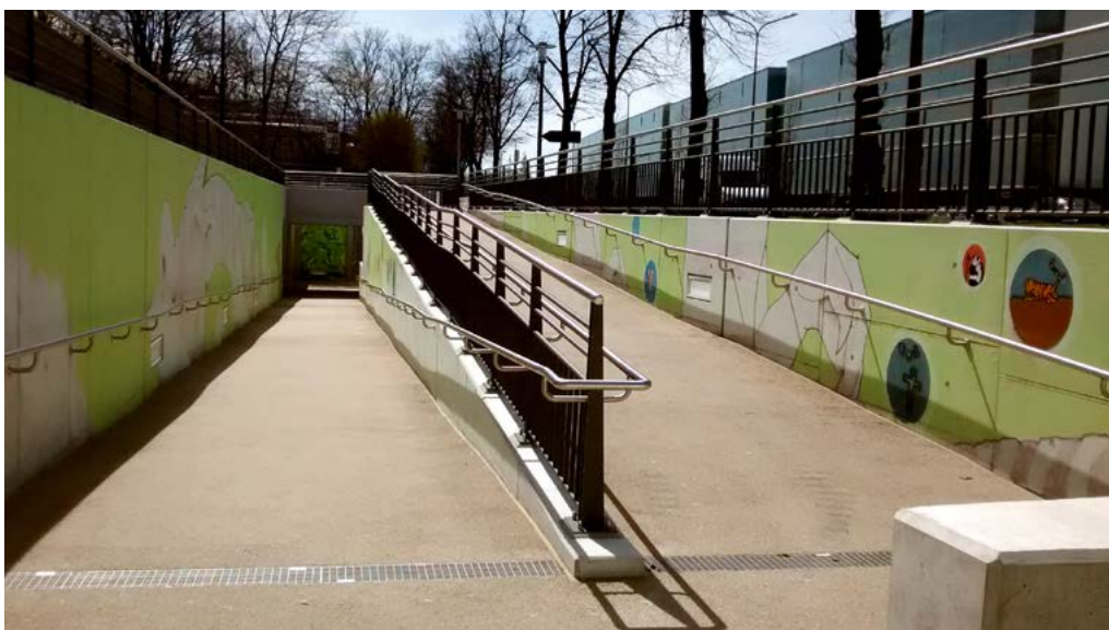
Barrierefreier Zugang zur Unterführung
