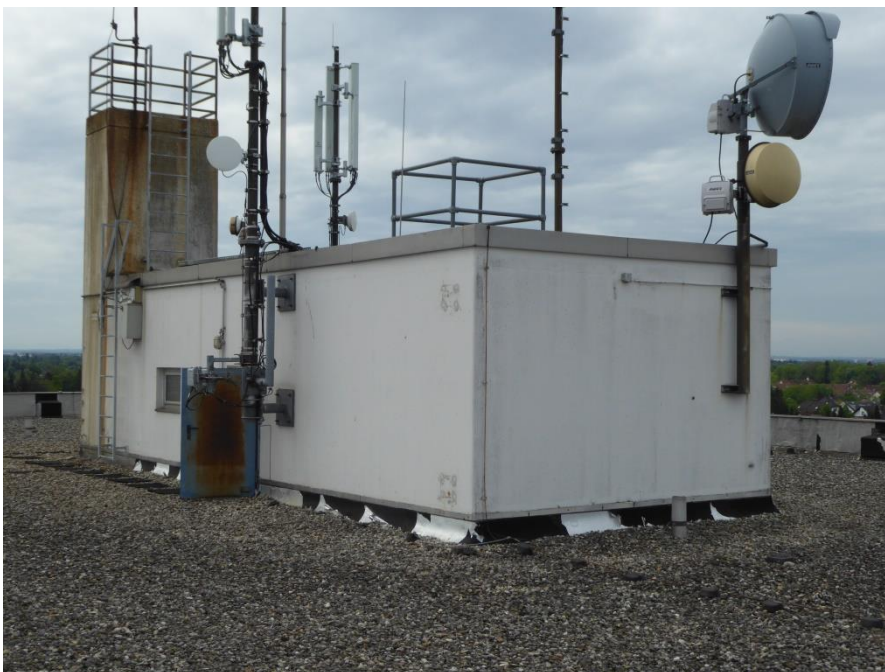
Abbildung 6: Die Aufbauten auf den Gebäudedächern weisen i.d.R. nur wenige Quartiermöglichkeiten für Fledermäuse auf.
