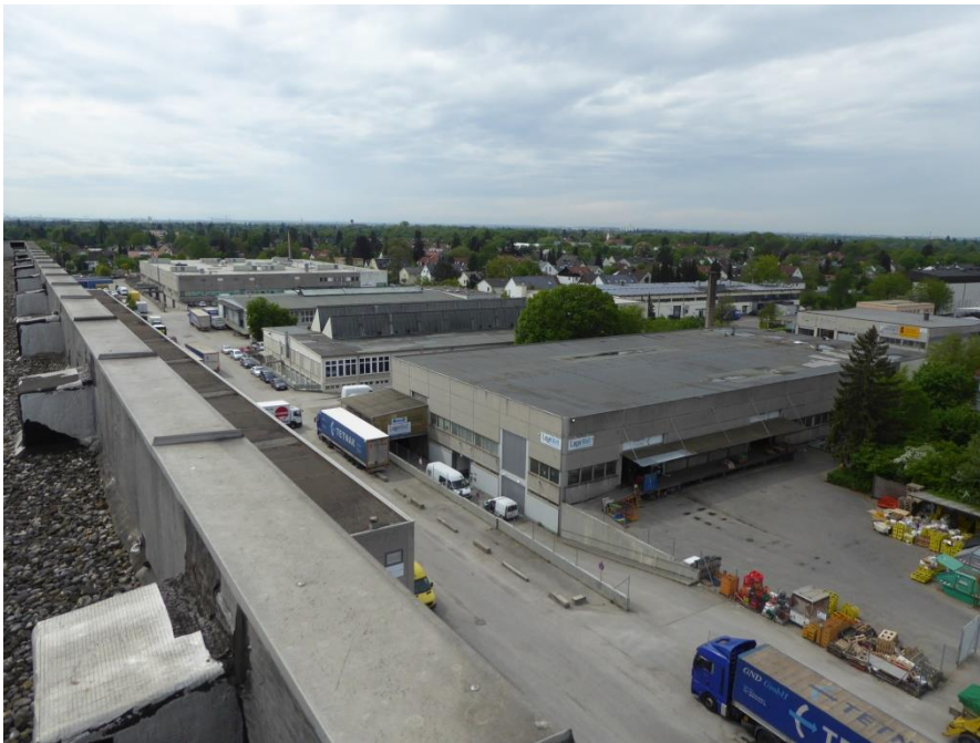
Abbildung 3: Typische Hallengebäude im Südwestteil des UG mit Flachdächern, umlaufenden Attikablechen und vorgelagerten Fassadenelementen (Blick nach Südwesten).
