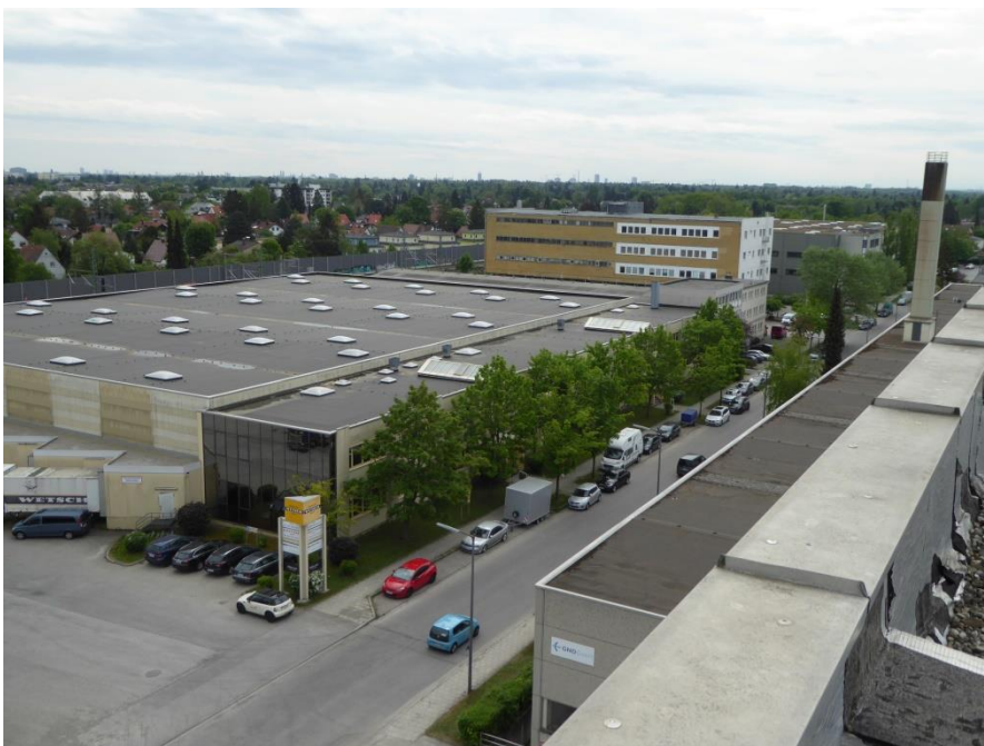
Abbildung 4: Gebäude im Südostteil des UG (Blick nach Südosten).
