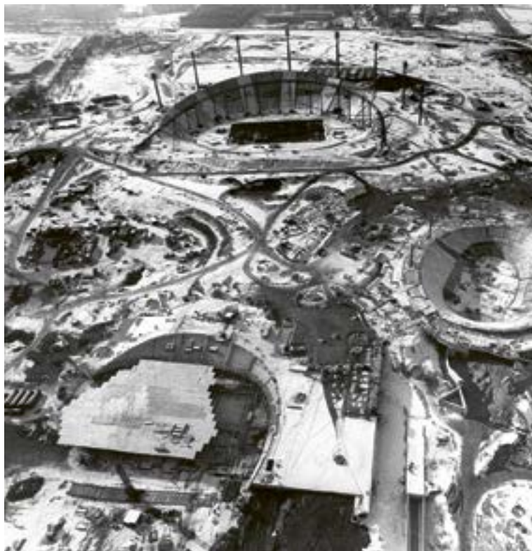
Europas größte Baustelle, 1970/71
