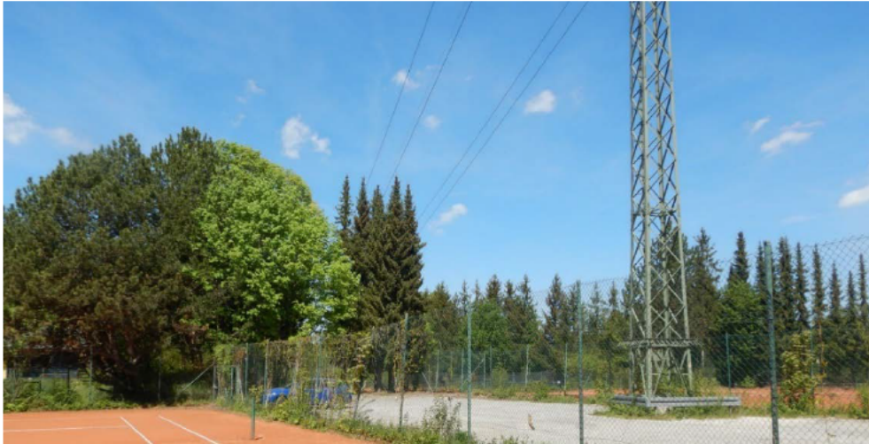
Abb. 6: Mastenstandort mit Blick nach Nordosten
