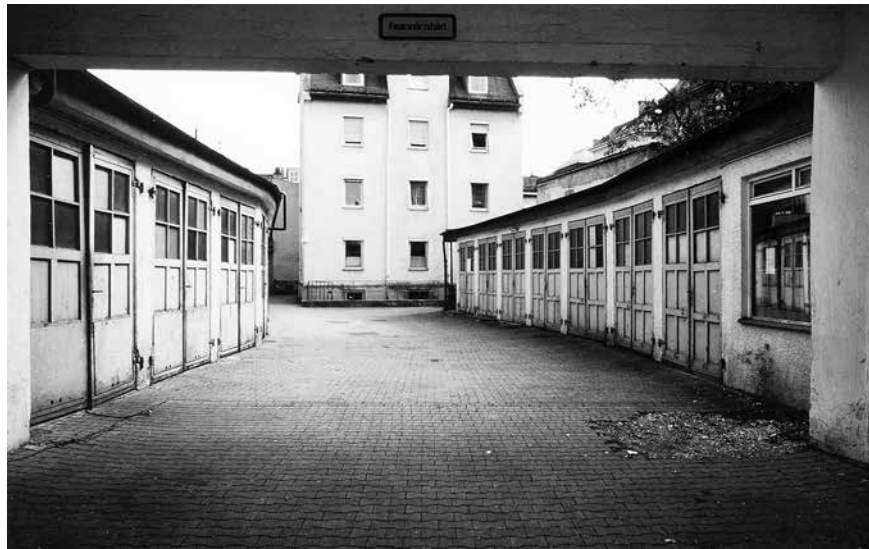
Ehemaliger Garagenhof Ganghoferstraße 13 vor Sanierung
