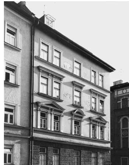
Tulbeckstraße 5 vor Sanierung
