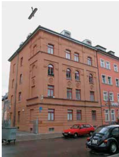
Tulbeckstraße 7 nach Sanierung
