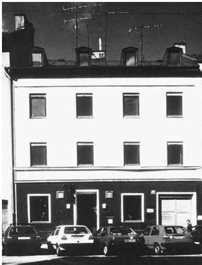
Schwanthalerstraße 118 vor Sanierung
