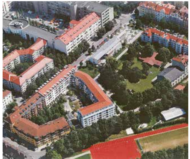
Luftbild Block 48 nach Sanierung aus dem Jahr 2001
