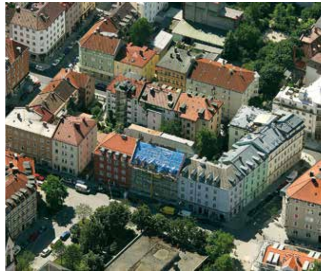
Luftbild aus dem Jahr 2005 nach der Sanierung
