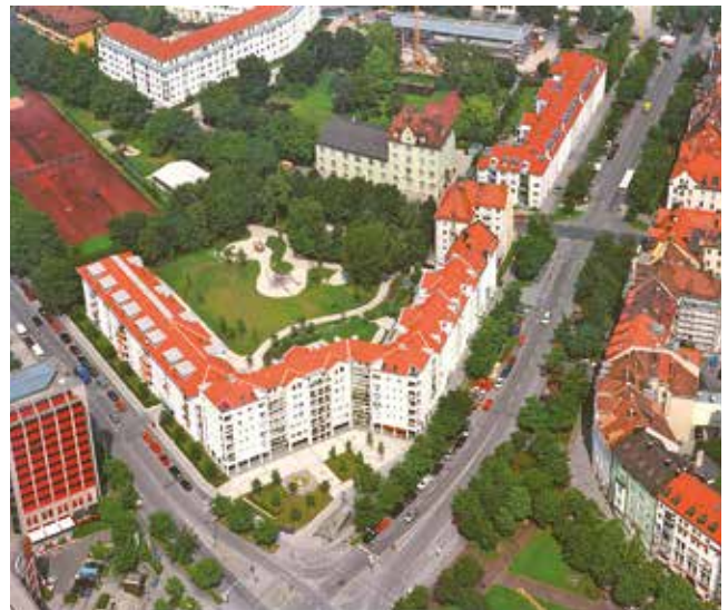
Luftbild Block 49 nach Sanierung aus dem Jahr 2001
