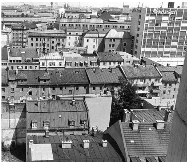
Vordergrund Mitte/links: Ausschnitt Sanierungsblock 3 vor Sanierung
