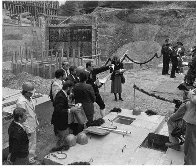
Grundsteinlegung Wohnanlage (sozialer Wohnungsbau) im Block 21
