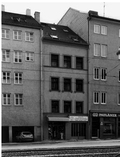
Landsberger Straße 13 vor Sanierung
