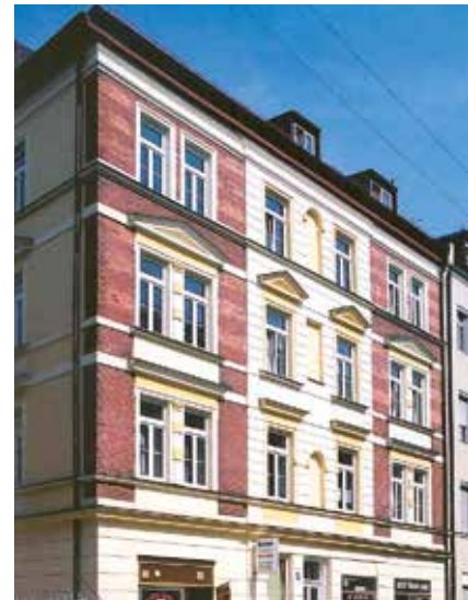
Gollierstraße 14 nach Sanierung
