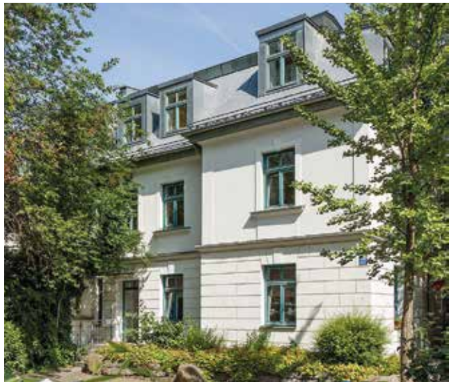
Innenhof Tulbeckstraße 6 und 6a nach Sanierung
