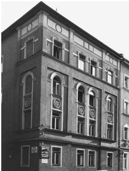
Tulbeckstraße 7 vor Sanierung
