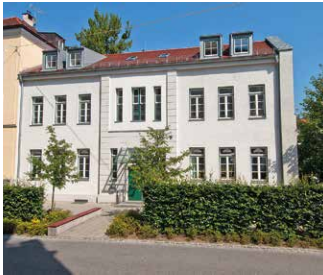
Westendstraße 68 nach Sanierung
