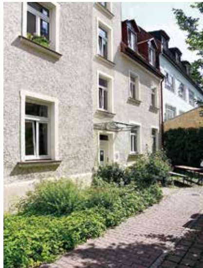
Gollierstraße 14 Rückgebäude nach Sanierung
