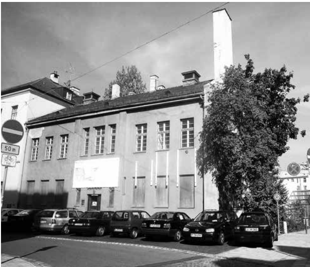
Tröpfelbad Westendstraße 68 vor Sanierung
