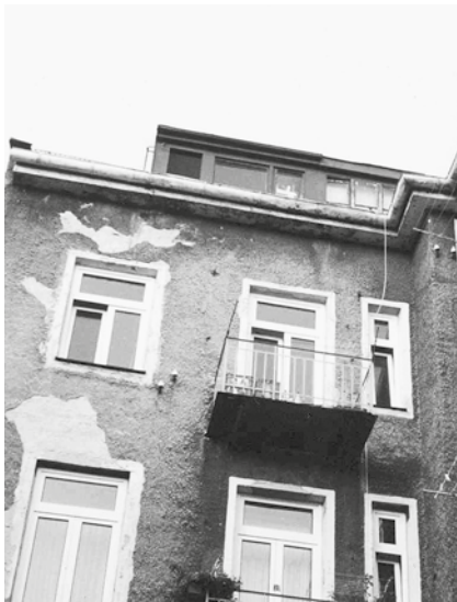
Gollierstraße 14 Rückgebäude vor Sanierung
