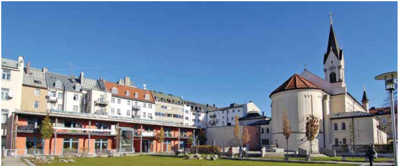
Soziale Einrichtungen Donna Mobile und Schrenkkirche unten: Klettergerüst im Innenbereich Block 18
