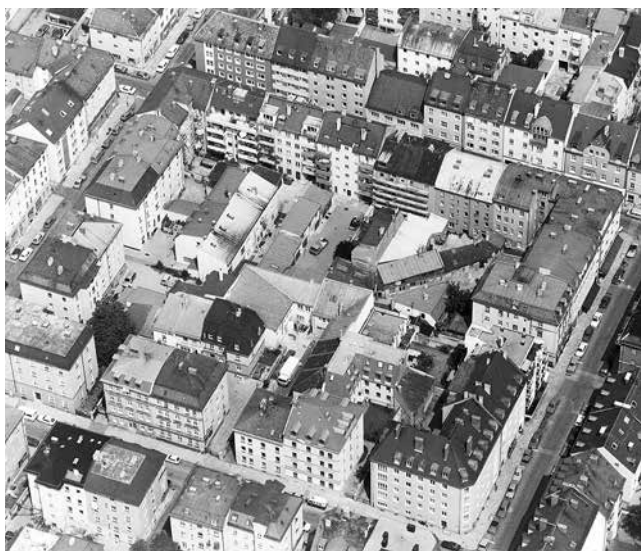
Die Sanierungssatzung des Blocks 8 trat mit Veröffentlichung im Amtsblatt am 20.07.1989 in Kraft. Luftbild aus dem Jahr 1986
