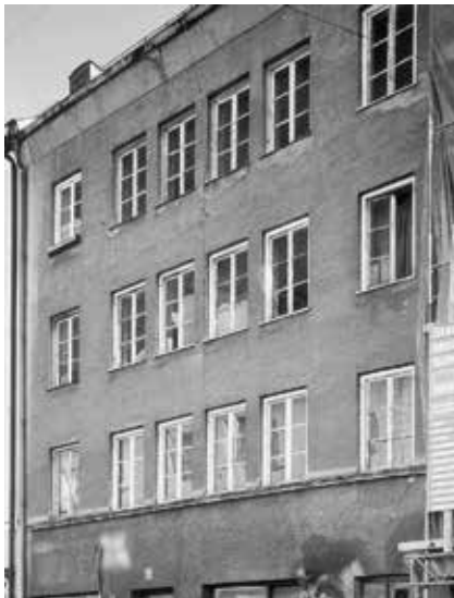
Schwanthalerstraße 133 vor Sanierung
