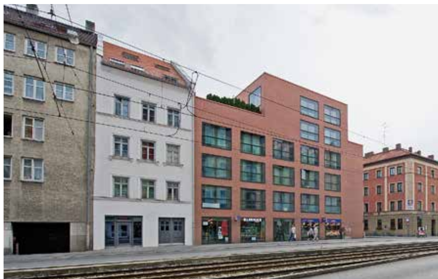
Landsberger Straße nach Sanierung
