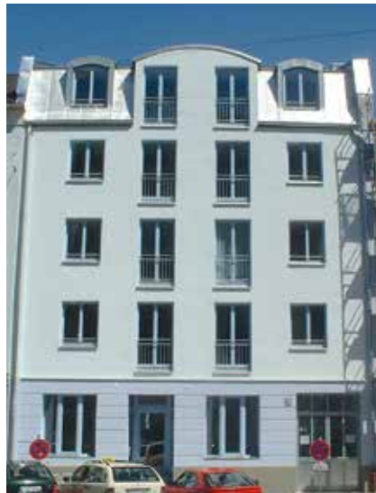
Schwanthalerstraße 118, Neubau „Drei-Liter-Haus“, Straßenfassade
