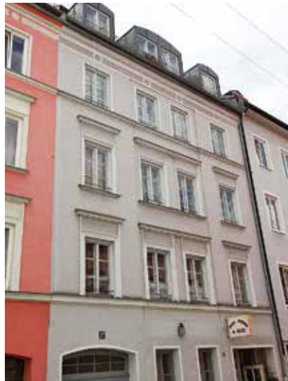
Westendstraße 47 nach Sanierung
