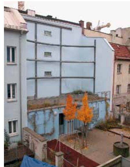
Schwanthalerstraße 118, Stützgerüst und Sonnendeck auf Bestandsgebäude (Rgb.)
