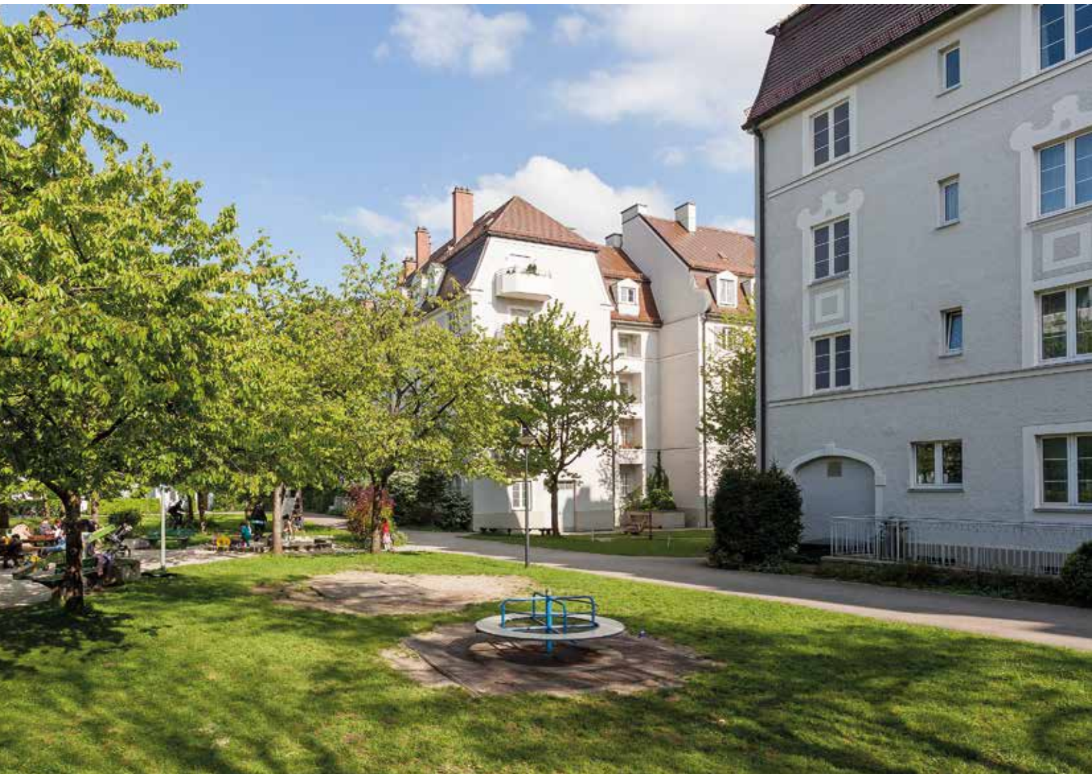
Innenhof Wohnanlage der Wohnungsgenossenschaft München-West nach Sanierung
