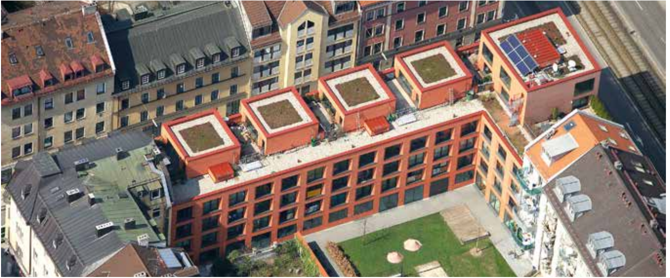
Luftbild Landsberger Straße 13/ Holzapfelstraße 3-5 nach Sanierung
