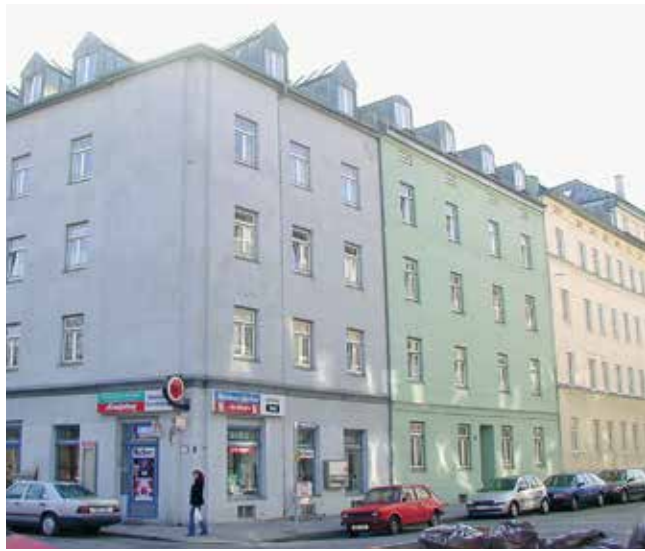
Ganghofer-/Westendstraße nach Modernisierung
