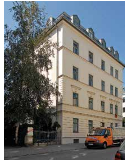
Tulbeckstraße 11 nach Sanierung
