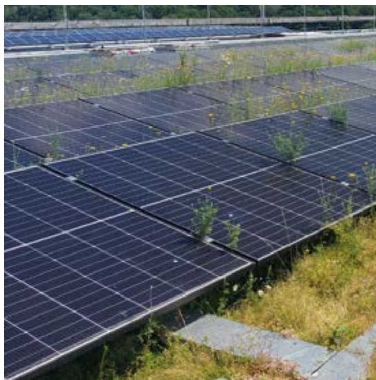
Pflanzen überwuchern PV Anlage bei zu geringem Abstand
