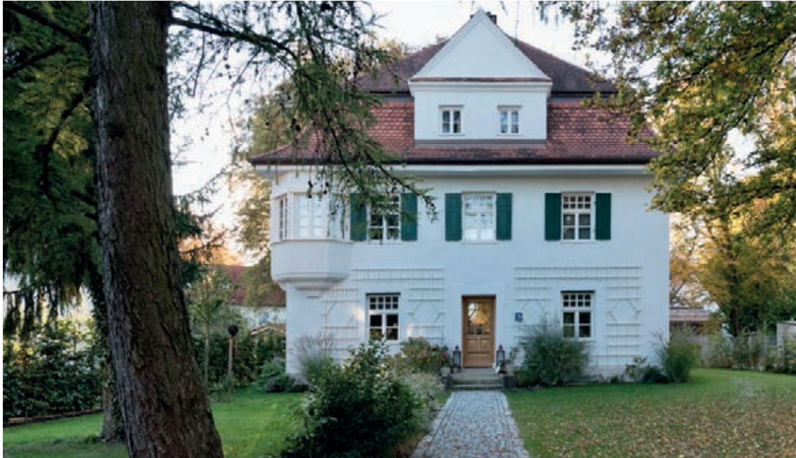
Ehem. Lehrerwohnhaus an der Schussenrieder Straße
