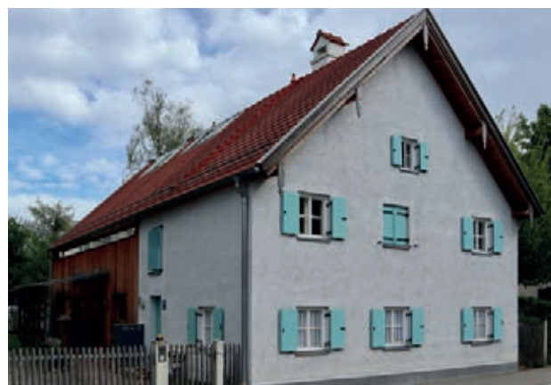
Hist. Kopfbauten mit neuen Anbauten
