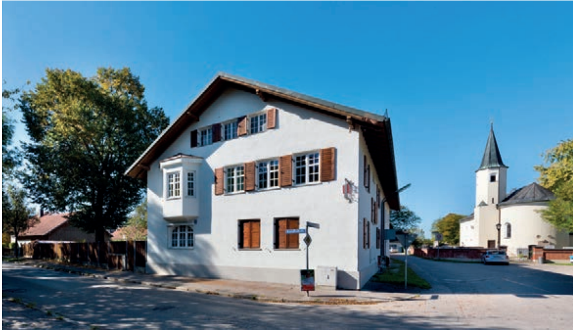
Ehem. Bauernhof an der Kuniuhohstraße
