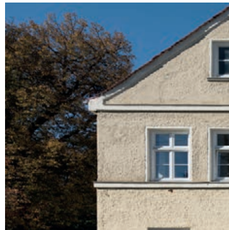
Fassadendetails des ehem. Schulhauses
