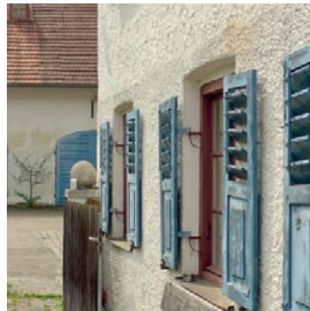
Kastenfenster mit Klapppläden
