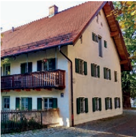
Ehem. Bauernhof an der Schmidbauerstraße
