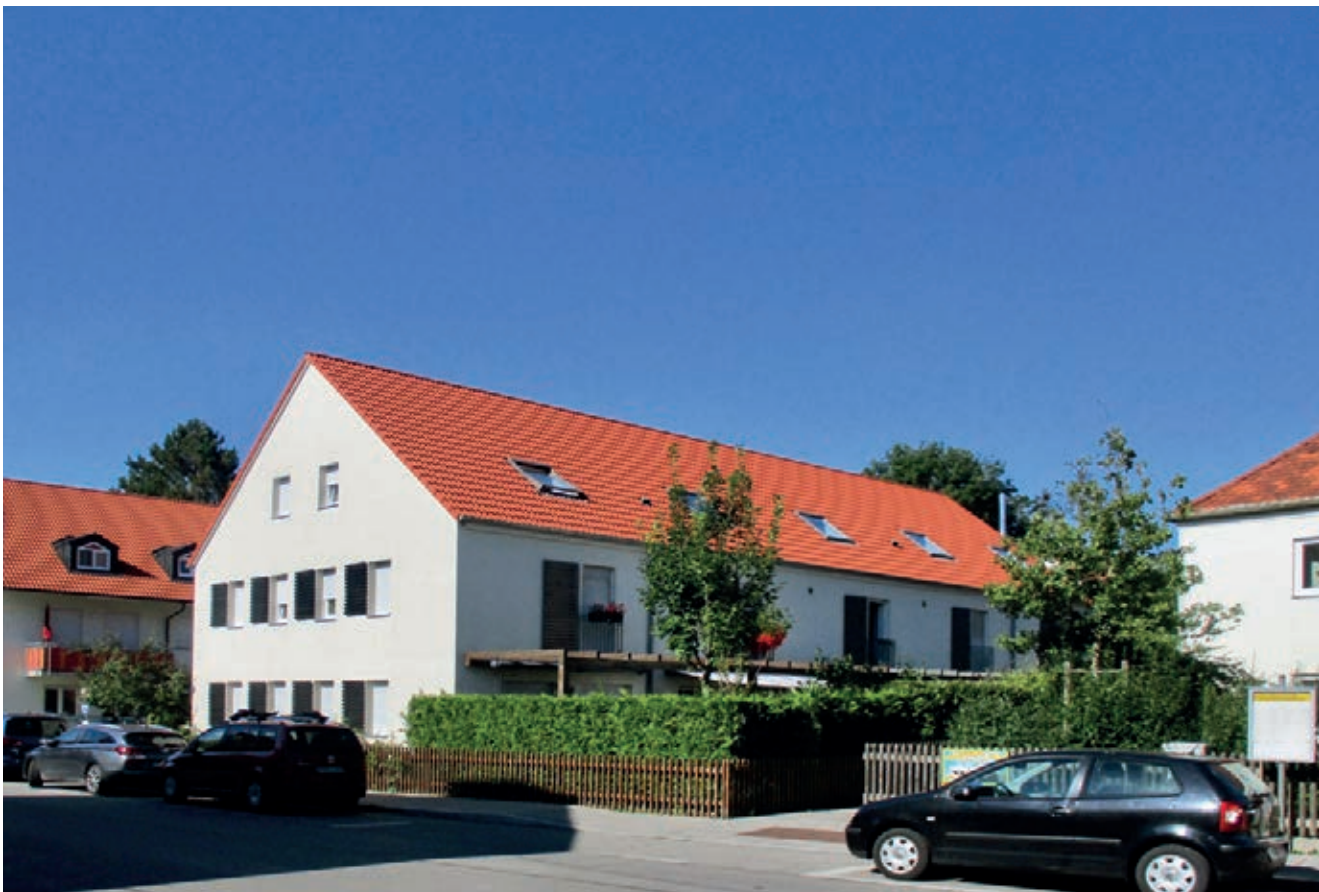
Ensemblegerechter Neubau in der Altostraße
