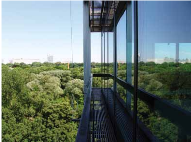
Fassadenausschnitt mit Putzbalkon
