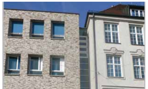
Fuge zwischen Alt- und Neubau
