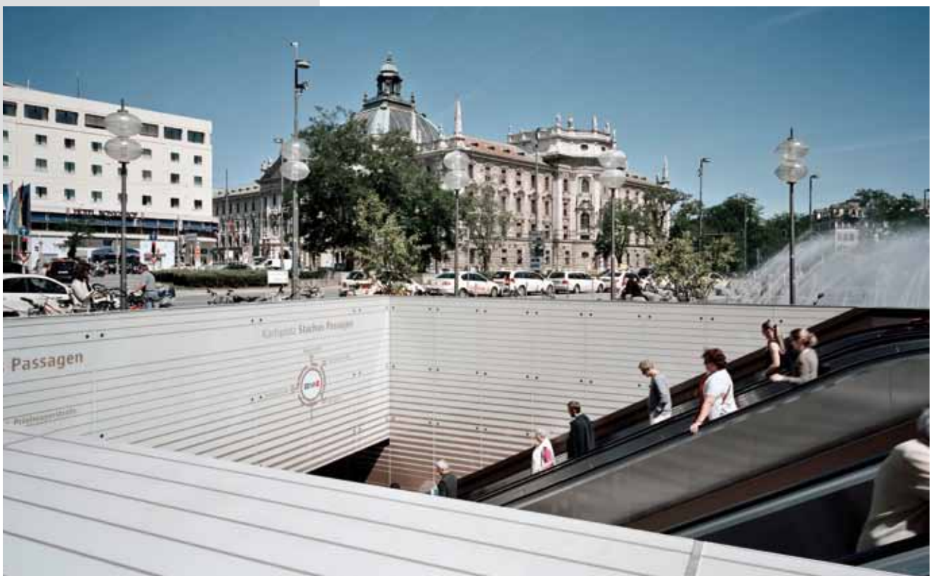
Zugang zum Untergeschoss
