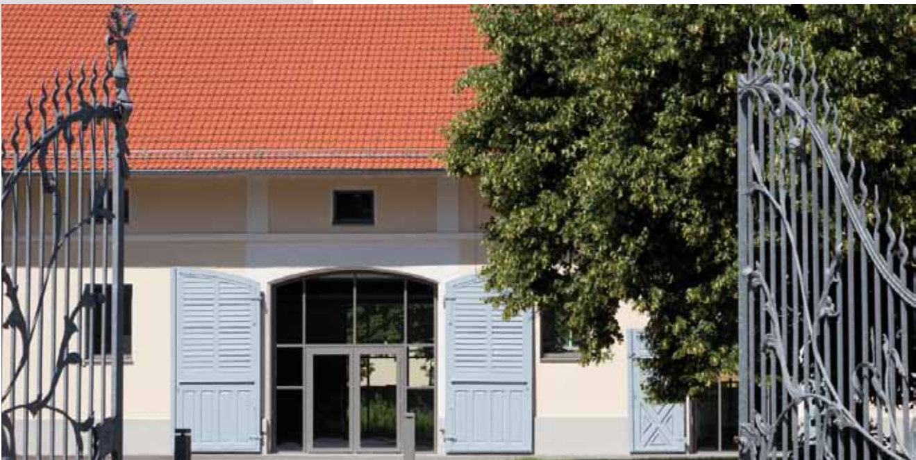
Blick durch das Einfahrtstor auf den ehemaligen Stadel
