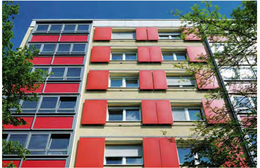
Meist sind Lärmschutzbausteine keine komplizierten und hochtechnischen Elemente. Vielmehr kommen einfache, aber wirksame Lärmschutzmaßnahmen, wie Schiebeläden oder Loggienverglasungen zum Einsatz.
