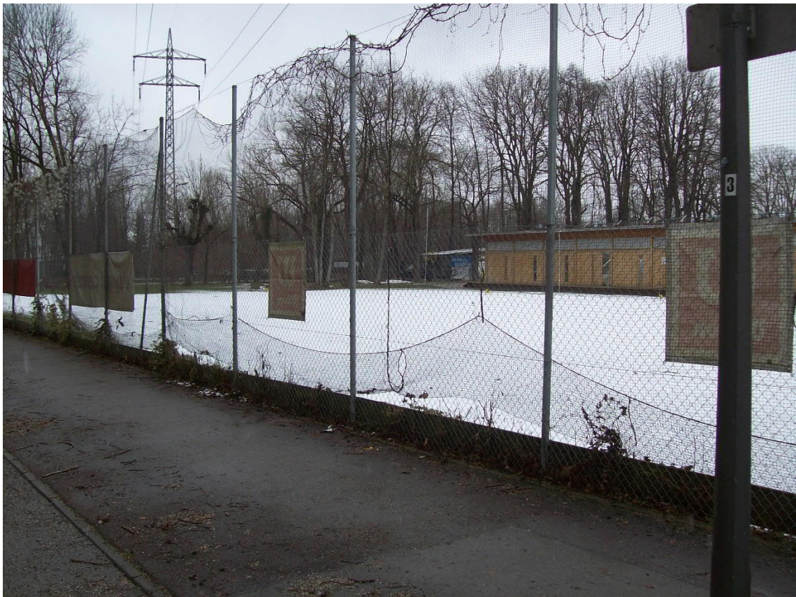
Bahnstromleitung (vom Emmerigweg aus fotografiert)
