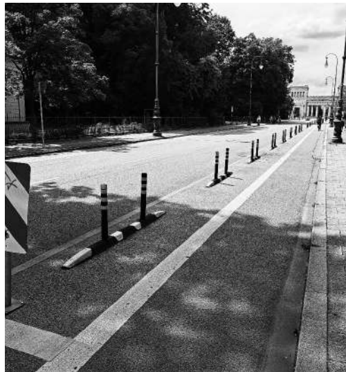
Safety first: Geschützter Radfahrstreifen in Richtung Königsplatz, München Safety first: Protected bike lane towards Königsplatz, Munich
