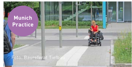
GETRENNTE QUERUNGEN, München In einem Pilotprojekt wurde 2022 erstmals eine getrennte Überquerungsstelle mit differenzierter Bordhöhe (0 / 6 cm) umgesetzt, um den Bedürfnissen blinder und gehbehinderter Menschen gerecht zu werden.
