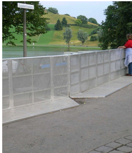
Abb. 13: Absperrung vor einem abfallenden Hang - Vorderansicht
