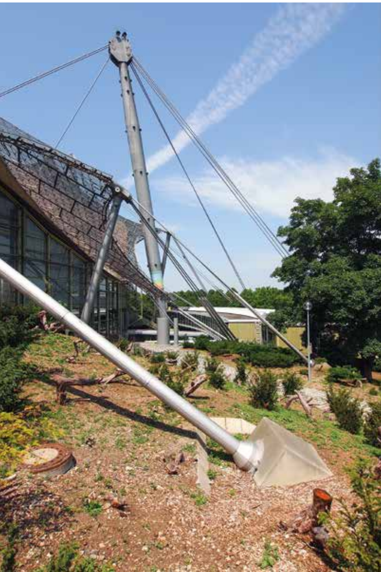
Abb. 2 Olympia-Gelände in München. Mast mit Abspannung, Foto: Jos Tomlow, 2015
