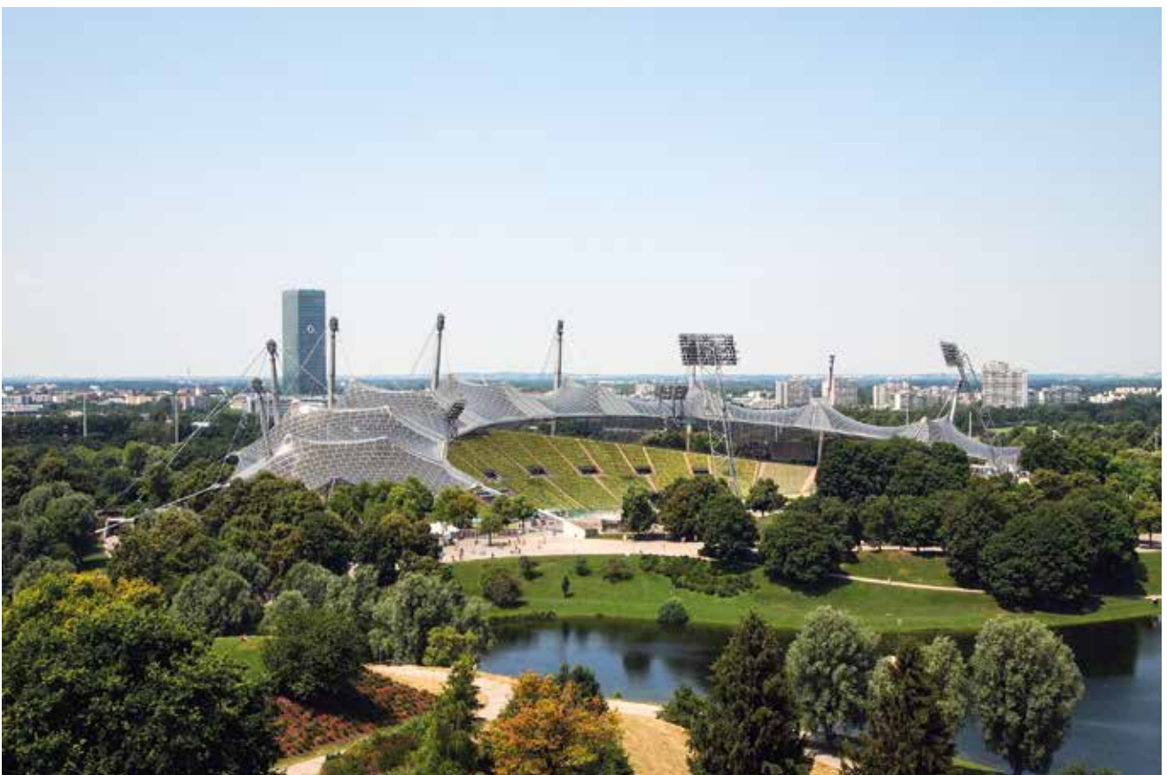
Abb. 1 Olympia-Stadion, Foto: Jos Tomlow, 2015
