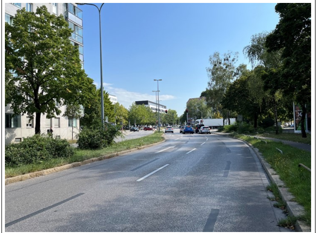
Werinherstraße westlich der Balanstraße; Blickrichtung nach Osten
