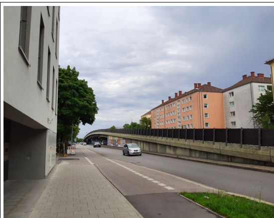
Frankfurter Ring an der Brücke über die Ingolstädter Straße; Blickrichtung nach Osten
