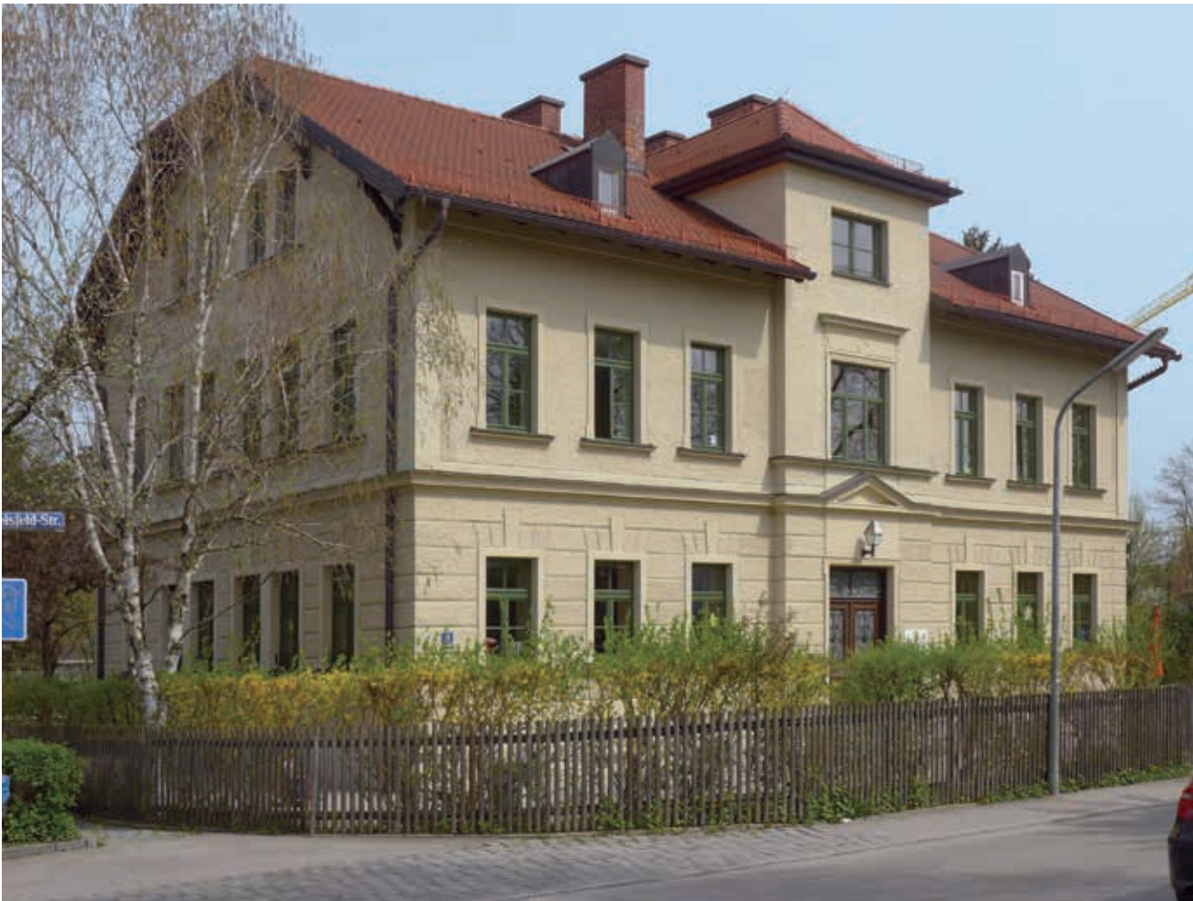
Ehemaliges Schulhaus am Rande des Ensembles
