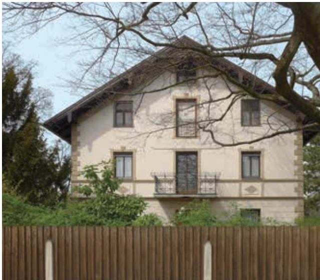
Wirkung im Ensemble: Flaschenträgerstr. 20
