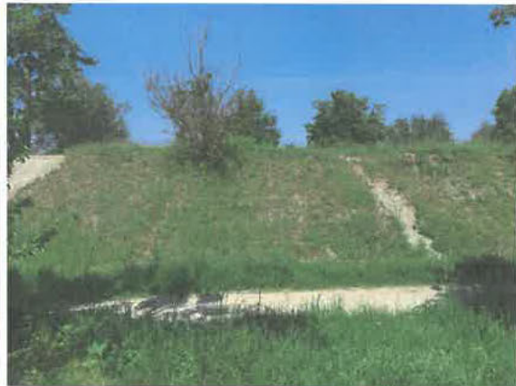
Wall der Kiestrasse westlich an das Flurstück Nr. 369 angrenzend
