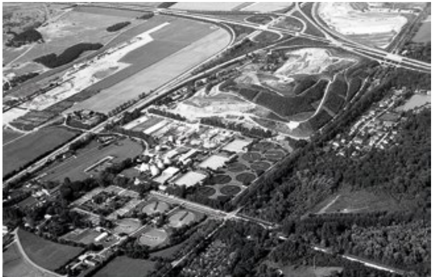
Klärwerk Gut Großlappen, 2010: Die neue Faulbehälteranlage und der neue Sandfilter sind in Betrieb.
