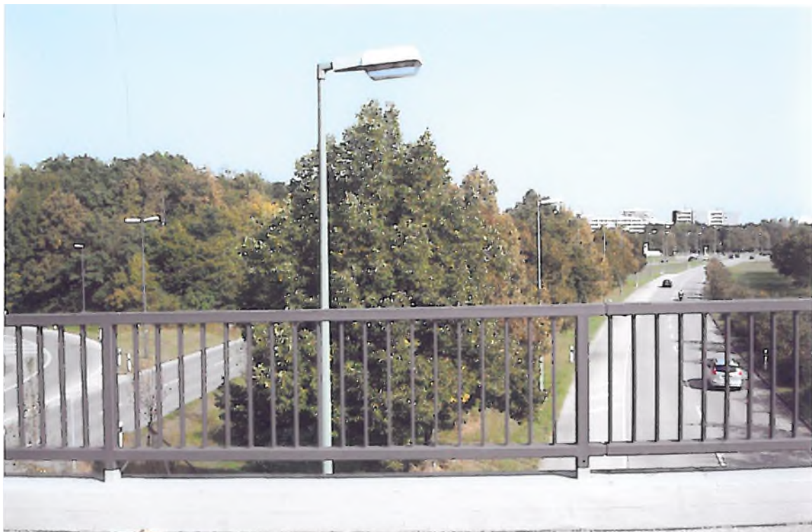
Blick von der Brücke der Albert-Schweitzer-Straße nach Osten, der Bogen im Hintergrund vor der Baumsilhouette, dahinter die Wohnbauten nordöstlich der Kurt-Eisner-Straße und Ständlerstraße
