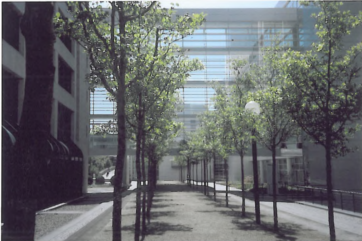
Hauptfußweg im Bereich zwischen zwei Bauteilen der Allianz
