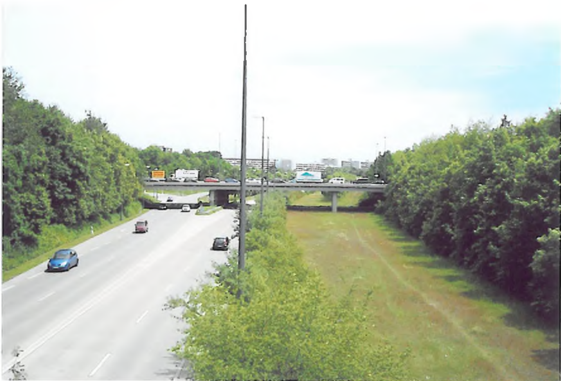
Ständlerstraße – Gesamte Schneise zwischen den Bauquartieren Nord (links) und Mitte (rechts), Blick von der Fußgängerbrücke bei der Allianz Richtung Osten, zur Brücke der Albert-Schweitzer-Straße und zum Bauquartier Nordost im Hintergrund
