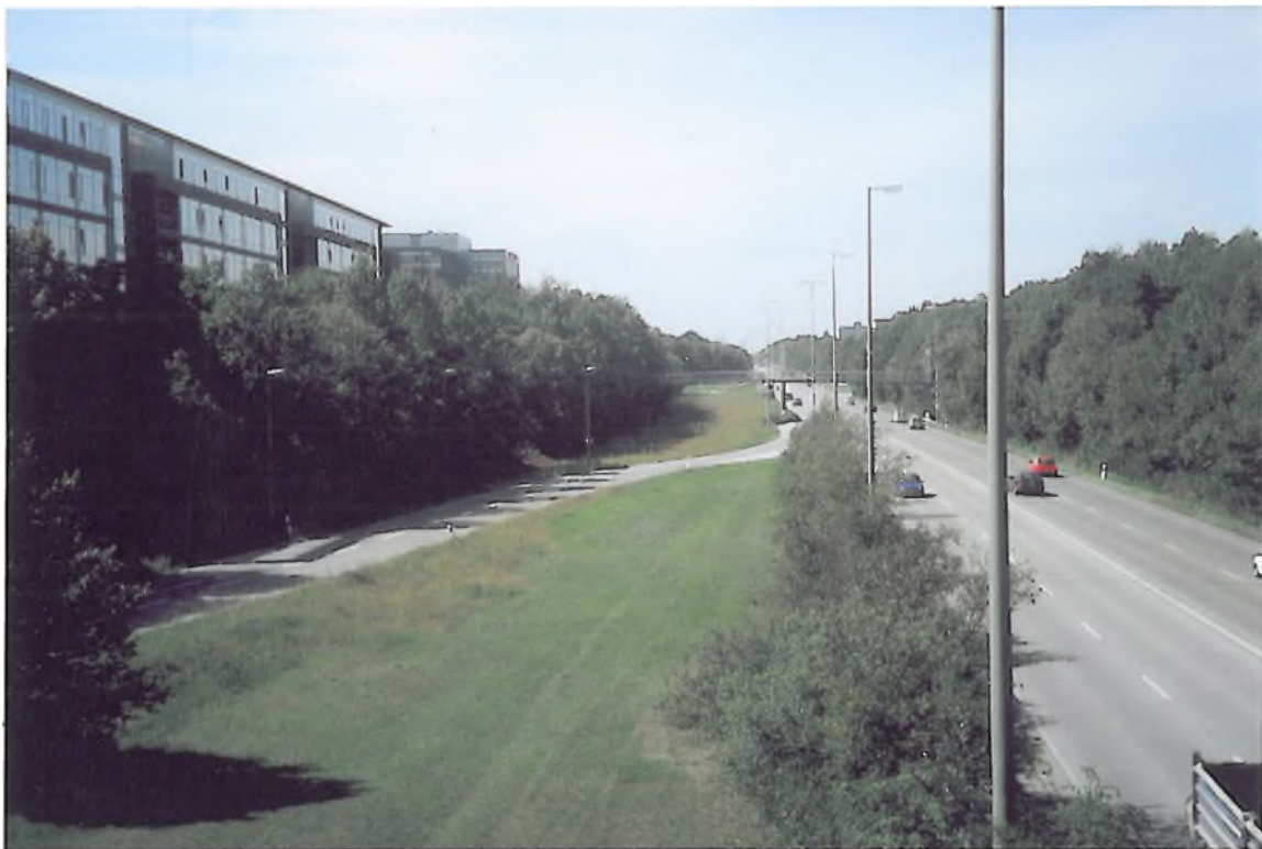
Blick von der Brücke über die Ständlerstraße Richtung Westen
