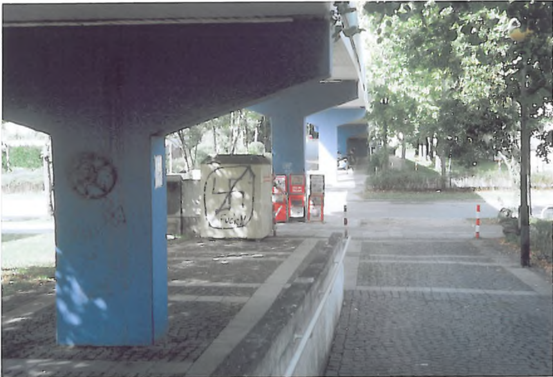
Die „Unterseite“ der Fußgängerbrücke am straßenbegleitenden Fußweg der Quiddestraße
