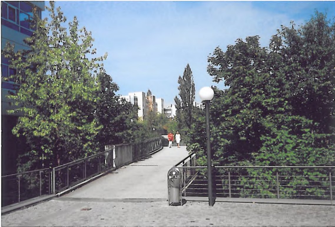
Brücke über die Ständlerstraße, Richtung Norden
