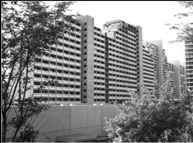
Vor der Sanierung mit Balkonen
