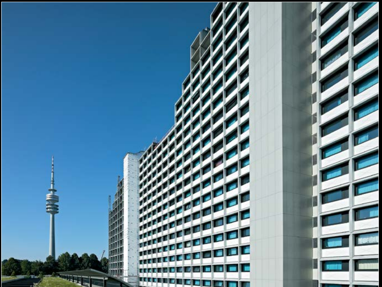
Das Gebäude nach der Sanierung
