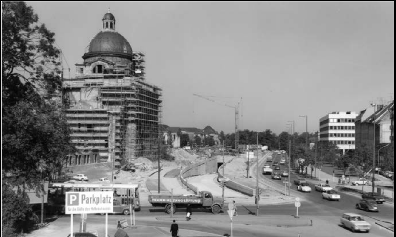
Bau des Altstadt-Tunnels, 1968
