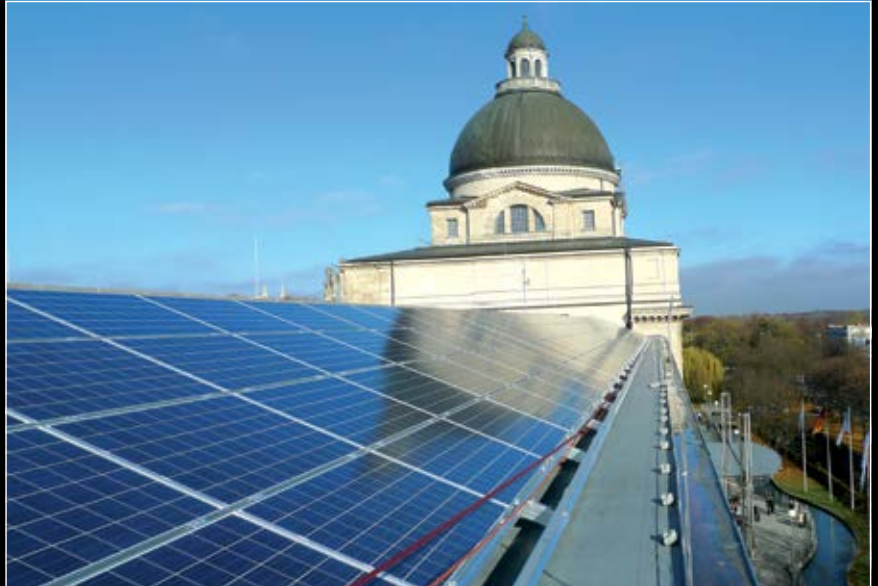
Blick Richtung Norden
