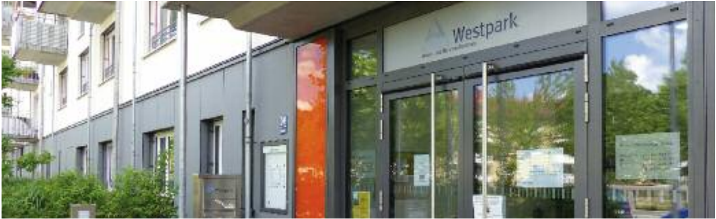
Alten- und Service-Zentrum Westpark
