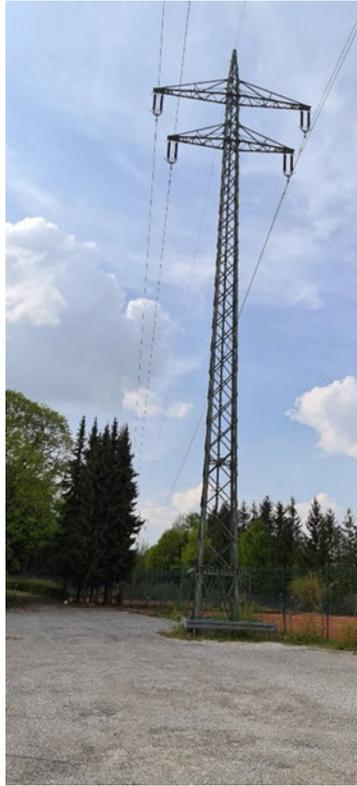
Bild 4: DB-Freileitungsmast mit 110kV-Freileitung, Schutzauflagen beachten!
