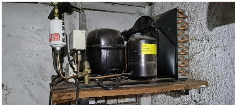
Bild 23: Kühlaggregat für Kühlkammer
