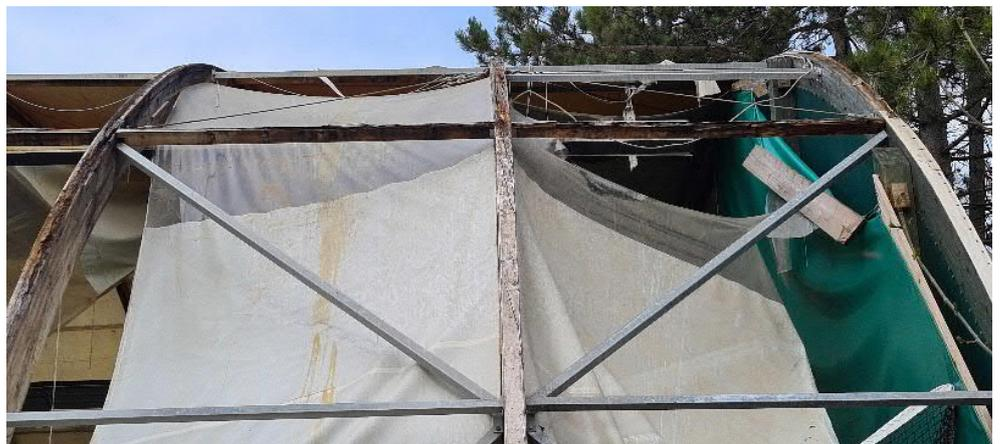
Bild 19: Schadstellen Tonnendach West mit Stahlprofilverstärkungen
