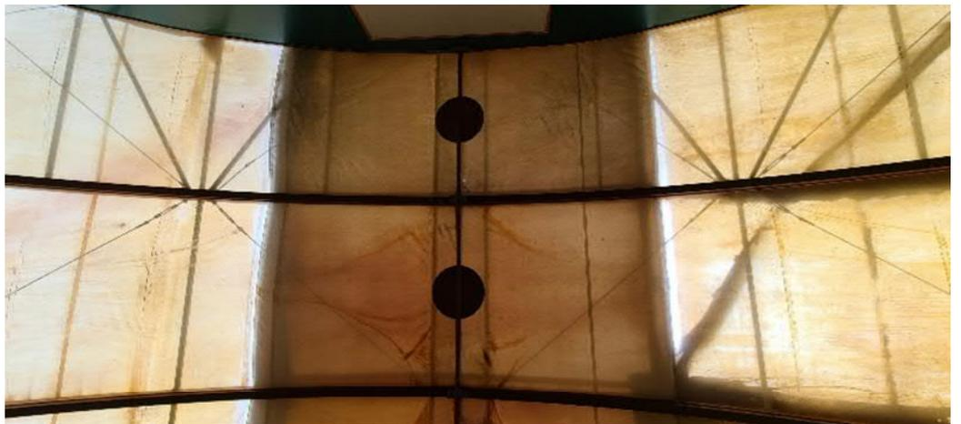
Bild 21: Blick auf First des Tonnendaches (innen), Stahlverstreben zwischen Holzleimbindern
