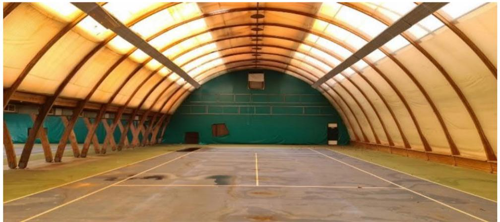
Bild 14: nördlichster Tennisplatz der 3-fach-Halle, Holzleimbinder-Balkendachkonstruktion
