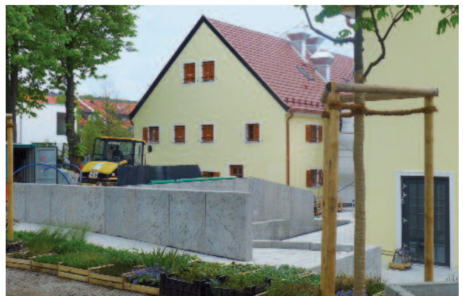
Absenkung der Hoffläche
