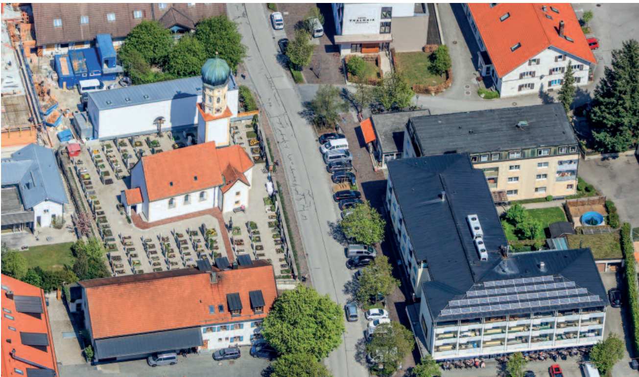
Das Ensemble von Süden
