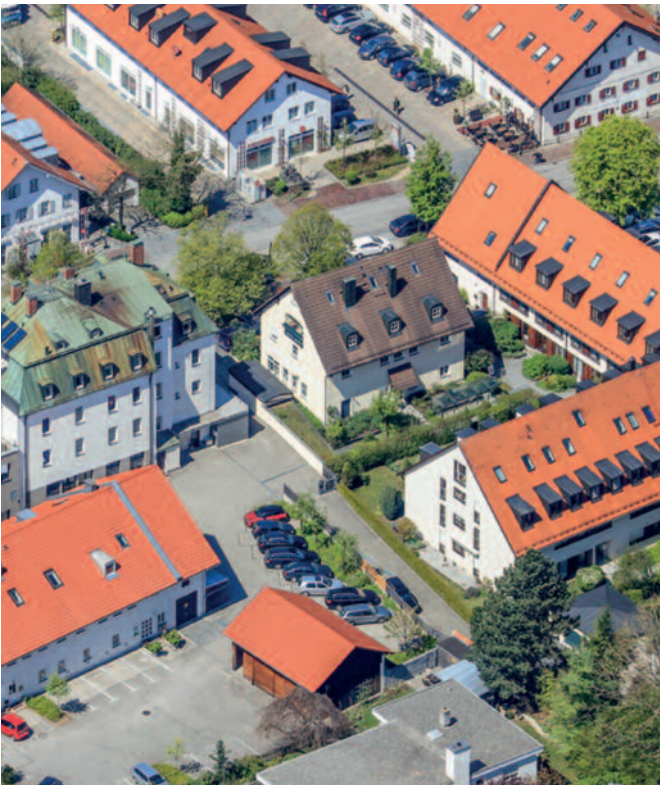
Dachlandschaft im Ensemble
