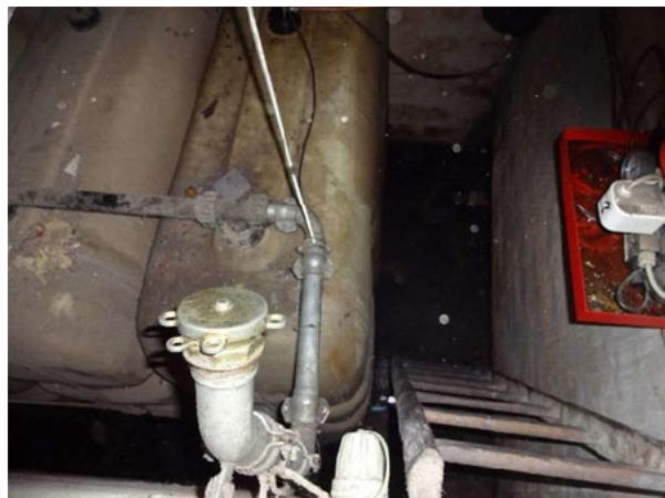
Abbildung 4: Heizöltanks im Lacklager ALVF -062
