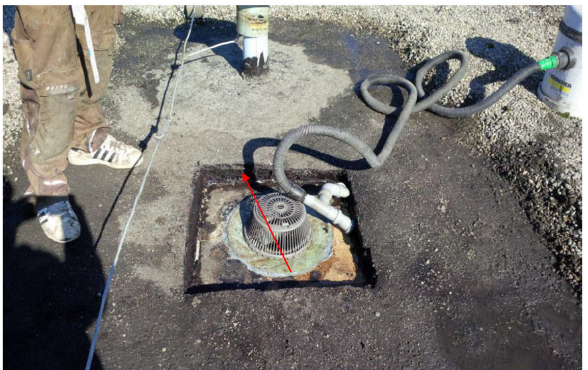
Foto 10: Gebäude K6, Dach (freigelegt wegen Reparatur) Teerpappe mit Teerkork-Zwischenlage
