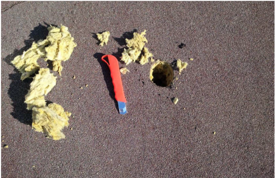
Foto 5: Gebäude K11, Dachpappe mit KMF-Isolierung
