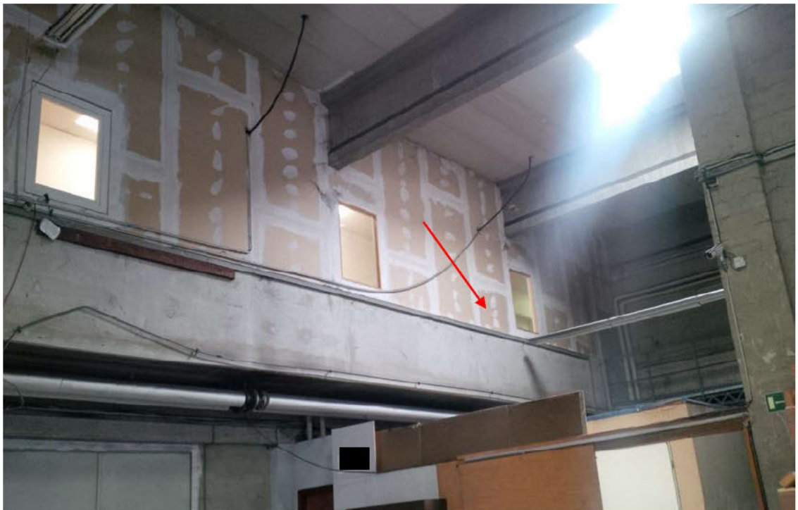
Foto 4: Gebäude K 11_13, Leichtbauwand, unverputzt
