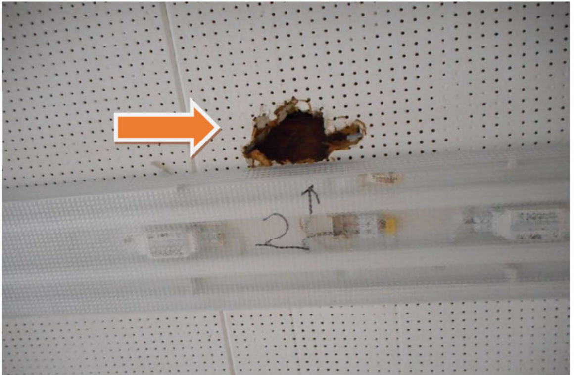
Foto 16: Gebäude Rhl, I. OG, Deckenplatten
