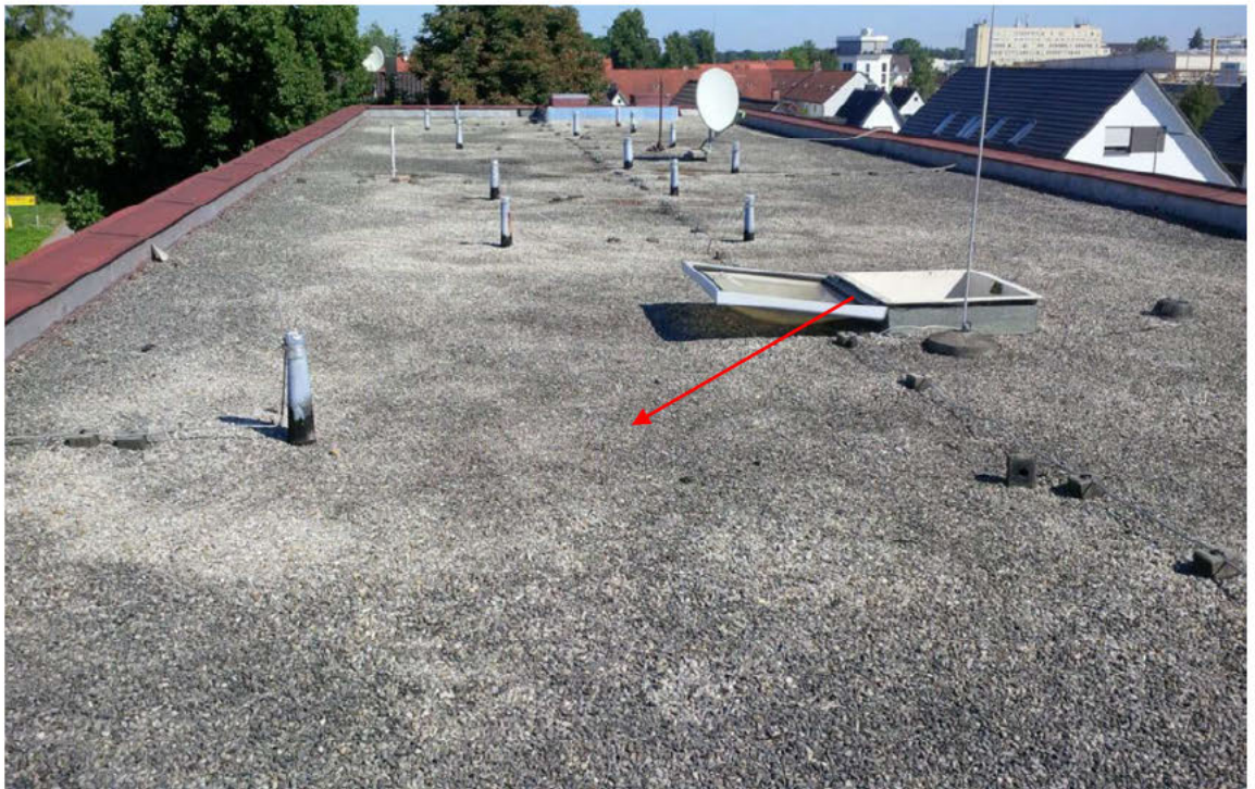
Foto 9: Gebäude K6, Dach Teerpappe mit Kiesschüttung
