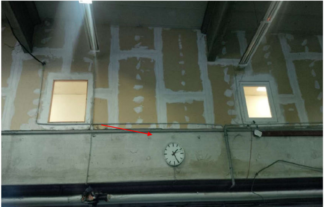
Foto 3: Gebäude K 11_13, Leichtbauwand, unverputzt
