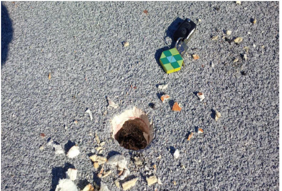
Foto 18: Gebäude RhII, Dach, Pappe mit Isolierung
