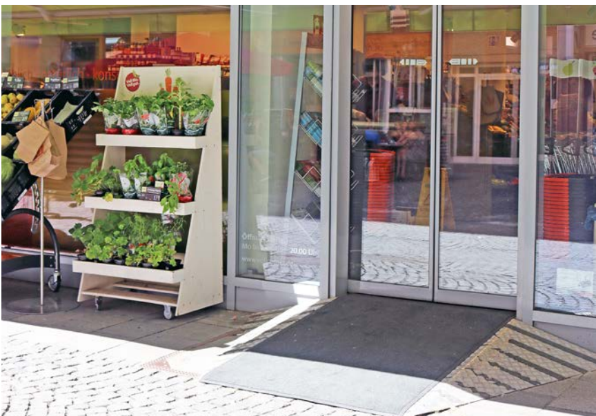
Nachgerüsteter barrierefreier Zugang zu einem Bio-Supermarkt in Haidhausen, München
