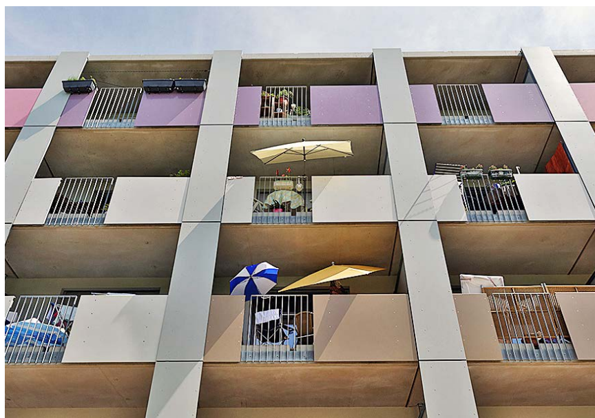
Projekt „WGplus Service“ (GWG) in Sendling-Westpark, München
