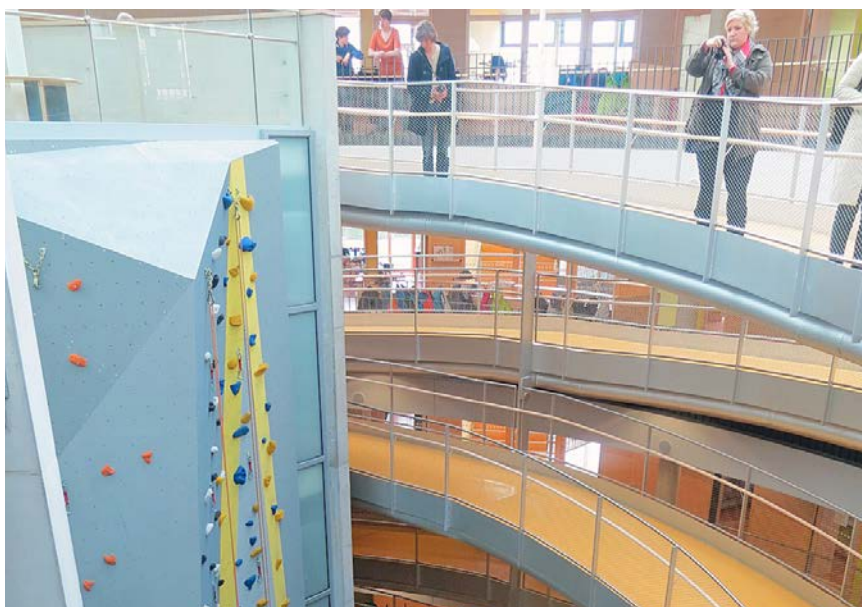
Das Atrium in der Barlachscheule in München ist barrierefrei als Rampenanlage gestaltet
