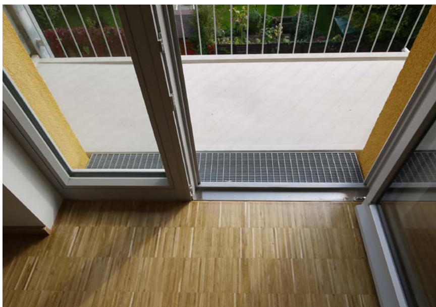
Übergang vom Wohnraum auf den Balkon in der Wohnanlage der GWG München am Humannweg
