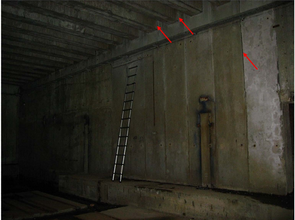
Abbildung 5: Geeignete Spaltenquartiere im Deckenbereich (seitlich der Decken-Betonträger) und zwischen den Betonplatten der Seitenwände (rote Pfeile, Länge der Leiter beträgt 5 m). (Quelle: Gerges 2019)
