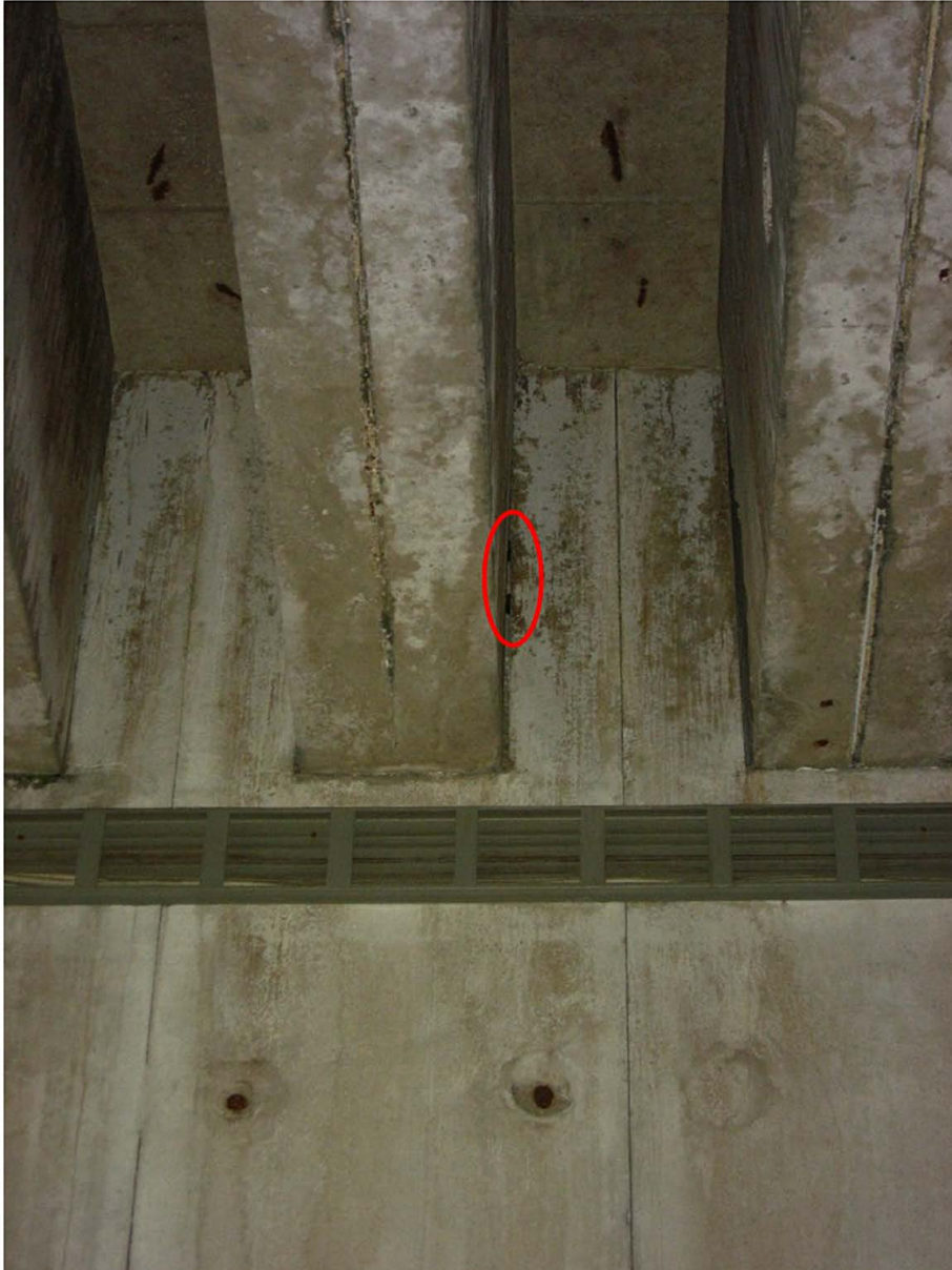
Abbildung 2: Zwei in einem Spaltenquartier seitlich eines Decken-Betonträgers übertagende Fledermäuse (roter Kreis). (Quelle: Gerges 2019)
