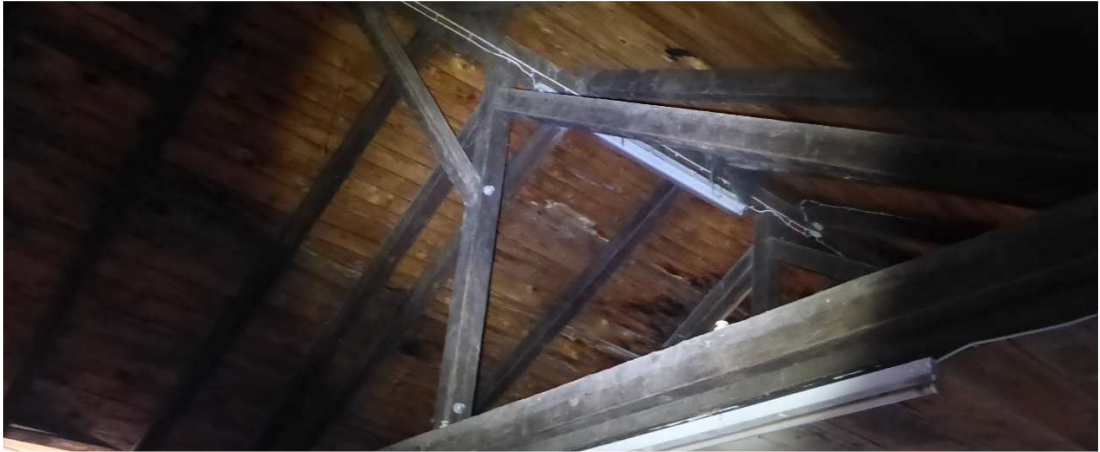
Abb. 22 Dachbereich des Schuppens 1
