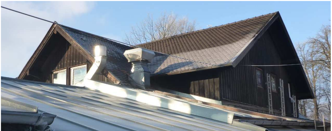
Abb. 11 Dachbereich des Wirtshauses
