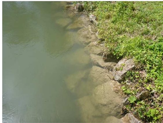
Abb. 27 Uferstruktur am Kanal im Südbereich
