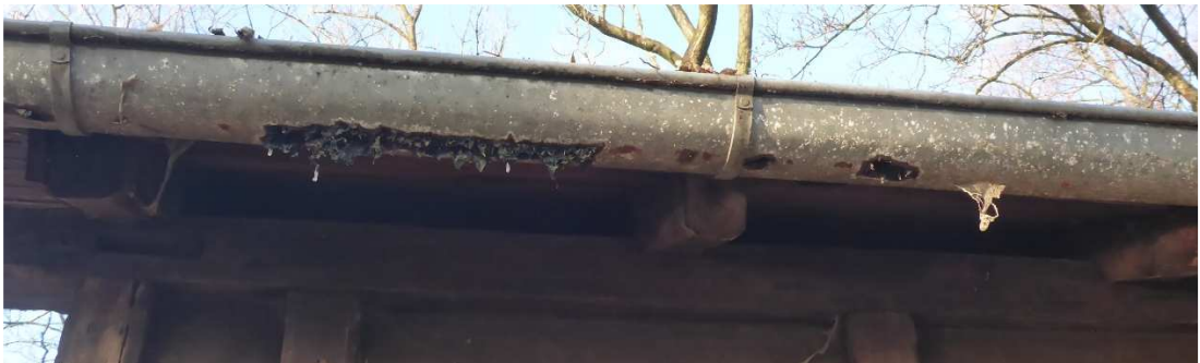
Abb. 20 Öffnungen am Dach des Schuppens
