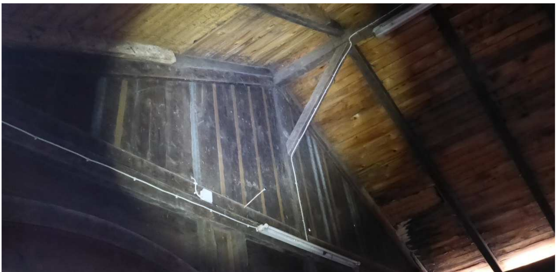
Abb. 23 Dachbereich des Schuppens 2
