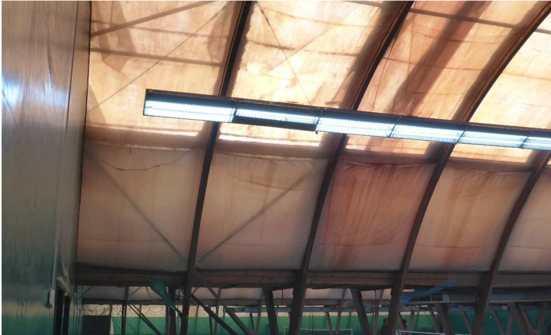
Abb. 6 Planendach der Tennishallen
