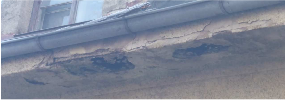
Abb. 12 Zahlreiche Versteckstrukturen außen am Gebäude
