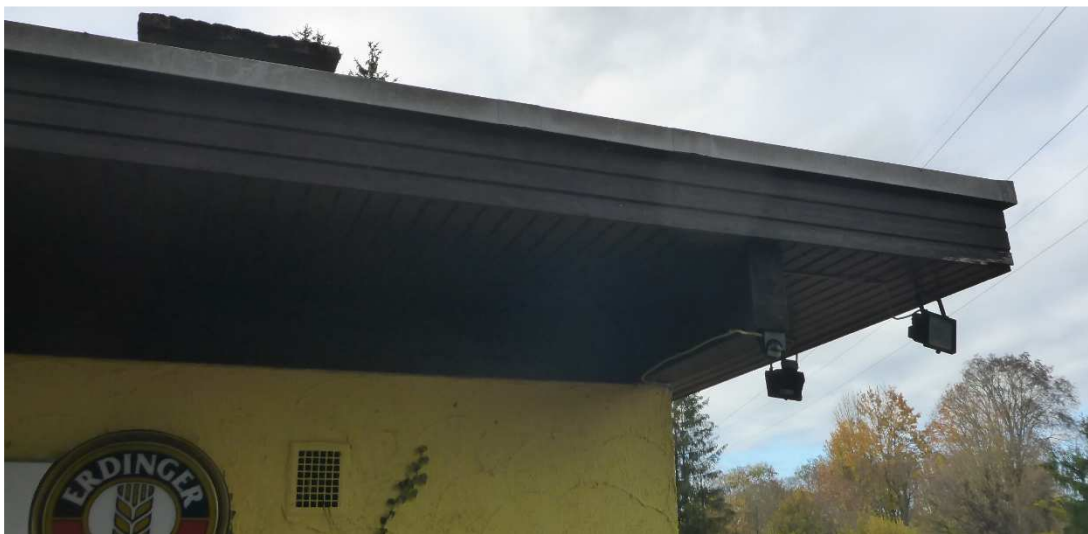
Abb. 5 Flachdach des Tennisplatzgebäudes
