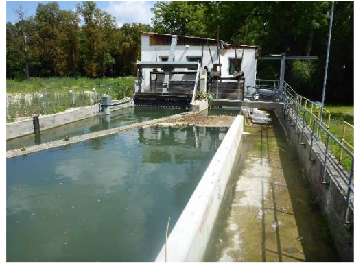
Abb. 26 Kraftwerksbauwerk auf Höhe des Sportgeländes
