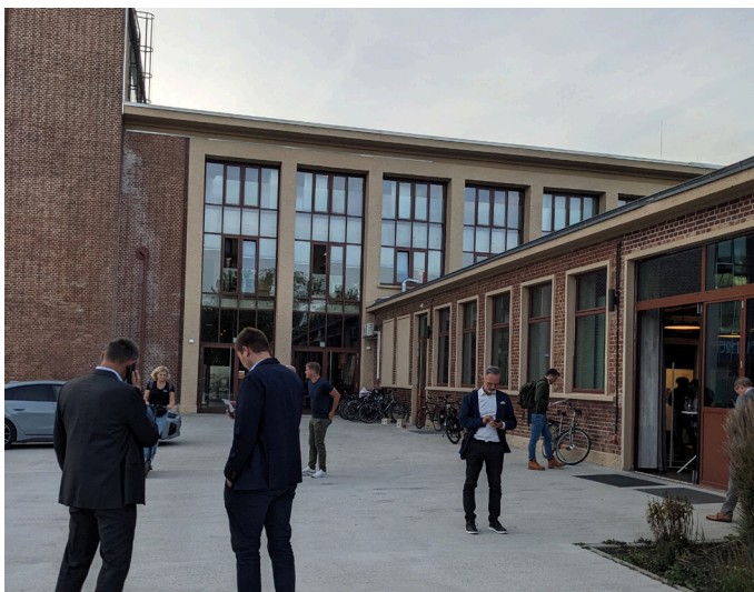
Eingang Gebäude 79, kleine Lokhalle
