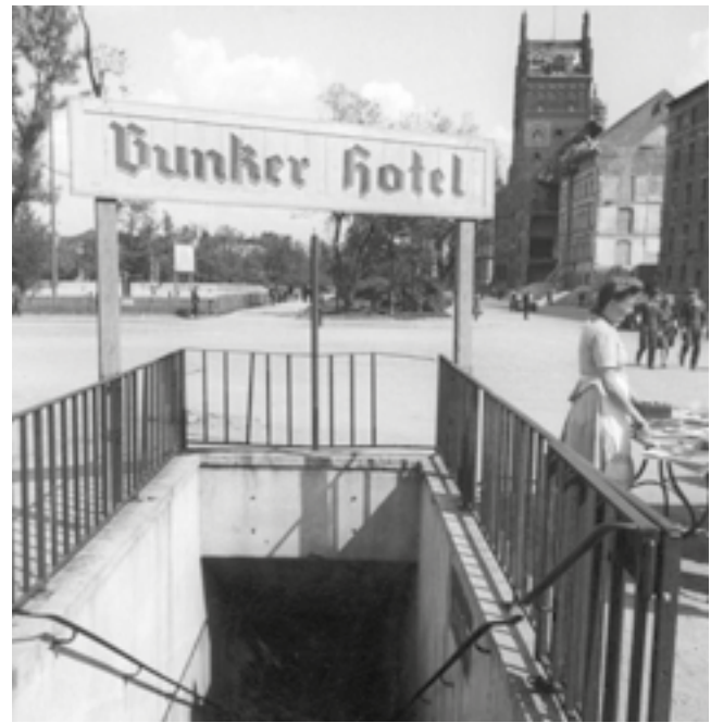
„Bunker-Hotel“ an der Ecke Luisen-Elisenstraße
