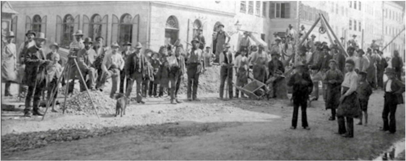
Bild von Kanalarbeiten aus dem Jahr 1893
